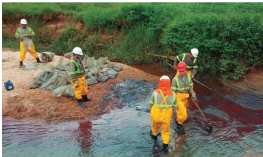
► Equipes especializadas continuam os trabalhos de manutenção, reforço e construção de contenções nos rios e ribeirões
