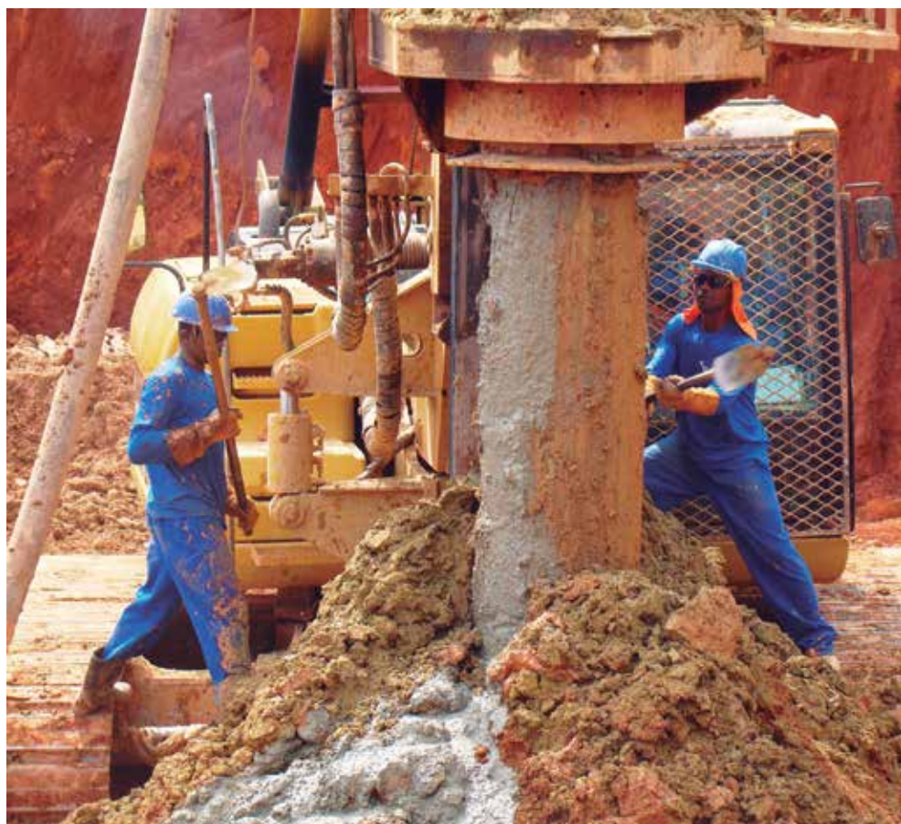
▲ O atendimento às especificações técnicas é fundamental para o sucesso da concretagem das fundações
