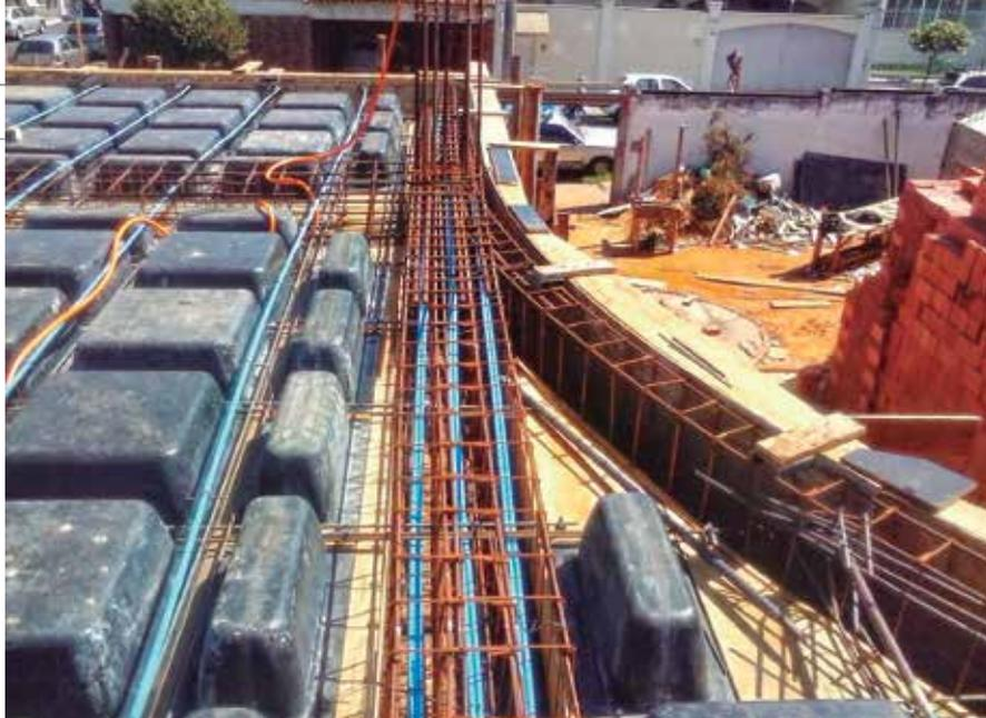
◀ Para ser utilizado em obras protendidas, o concreto deve apresentar resistência característica (fck) superior à do concreto armado
