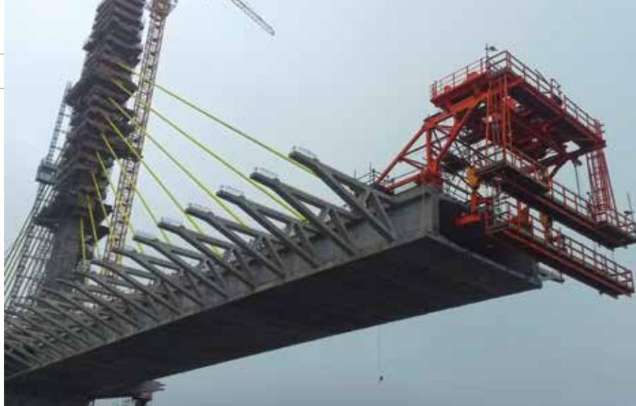
Após a colocação das cantoneiras, foram instaladas as pré-lajes para concretagem das duas pistas da ponte.
