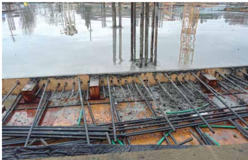
▶ Na foto, o concreto protendido com cabos pós-tensionados
