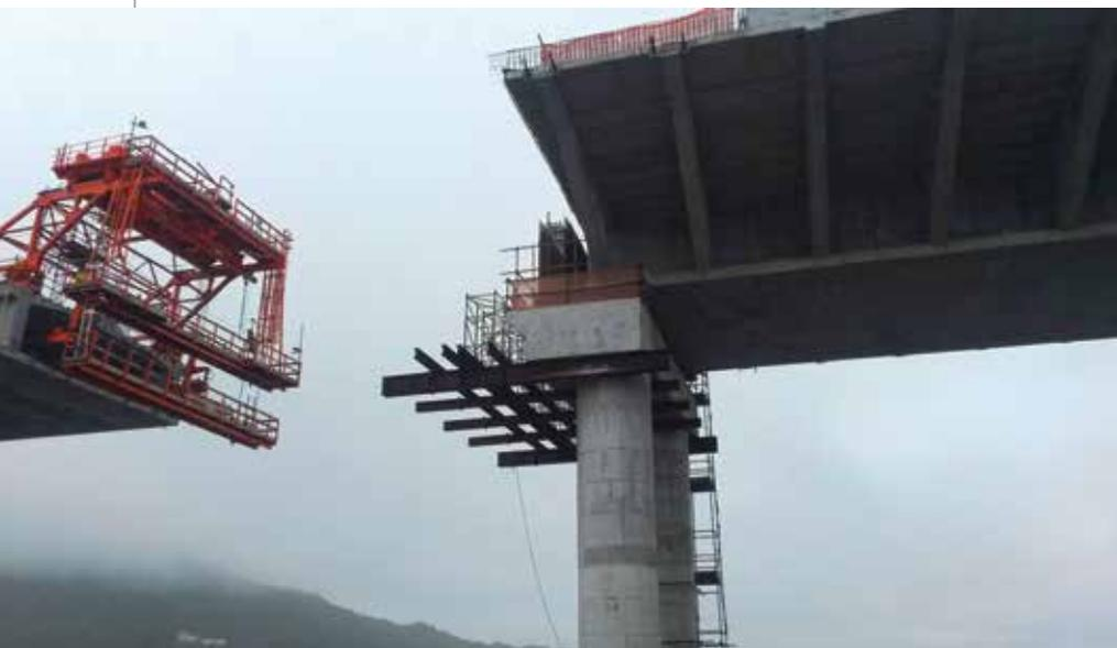
cionamento é repetida para cada aduela e a treliça-lançadeira avança sobre a estrutura já montada, para a montagem seguinte. A BERD-LG50 mede aproximadamente 131 metros de comprimento, tem 12 metros de altura, nove metros de largura e pesa aproximadamente 600 toneladas. Possui capacidade de executar e protender um vão de uma só vez e era o maior equipamento em operação no empreendimento.
