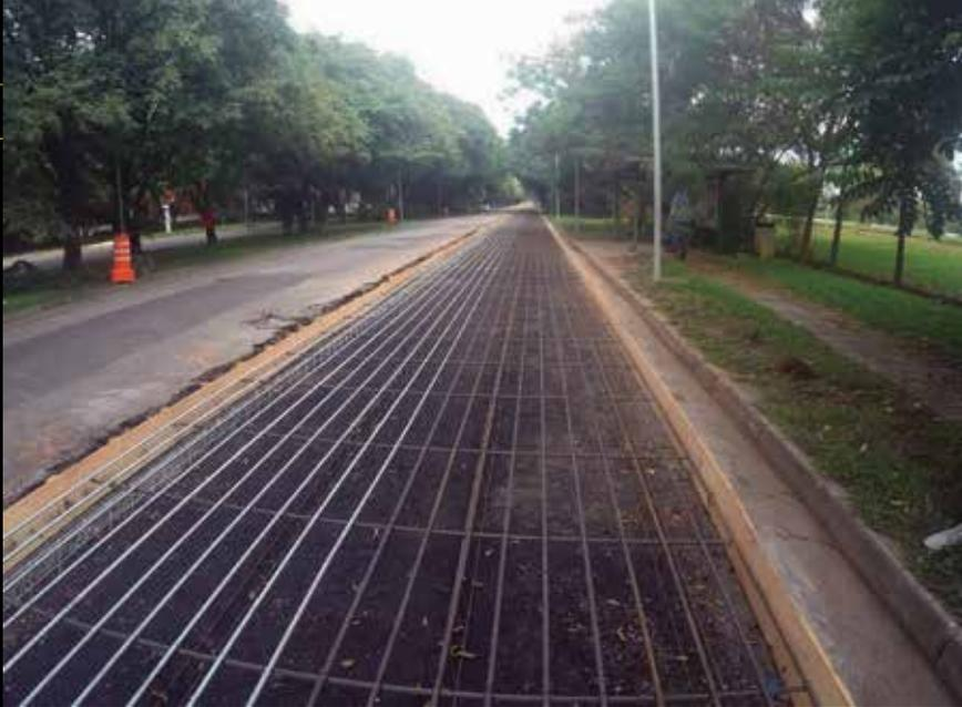
◀ A pista-teste foi segmentada em quatro partes, com tipos de concretos diferentes
