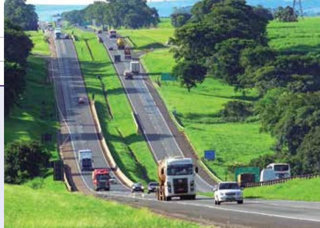
barreiras rígidas; Faixa de domínio de 50 m; Acostamento com 2,70 m; Faixa de segurança com 1,00 m; Rampa máxima de 8%.
