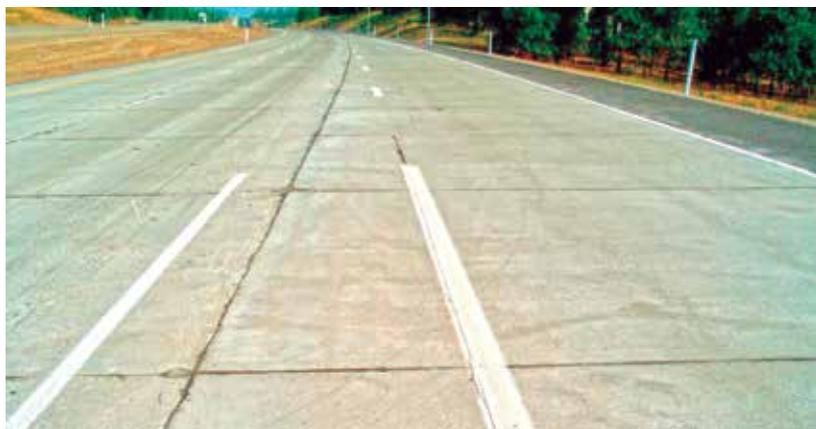
▲ A estrutura do pavimento rígido deve ser composta por placas de concreto com 24 cm de espessura e sub-bases de concreto rolado com 10 cm
