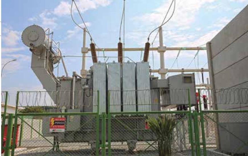
sopradores, motores geradores (na unidade de geração de energia que utiliza aterro) e uma unidade de transmissão da energia, com uma subestação composta de seccionadoras, disjuntor, transformadores de potência e de corrente e etc, painéis de controle etc.
