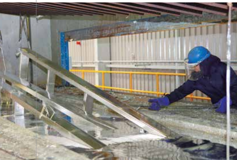
▲ Revestimento de estrutura metálica com zinco
