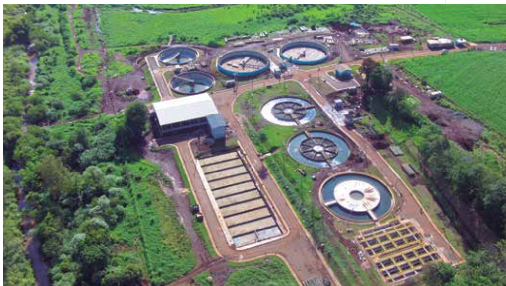
► Obras na ETE Mandacaru
