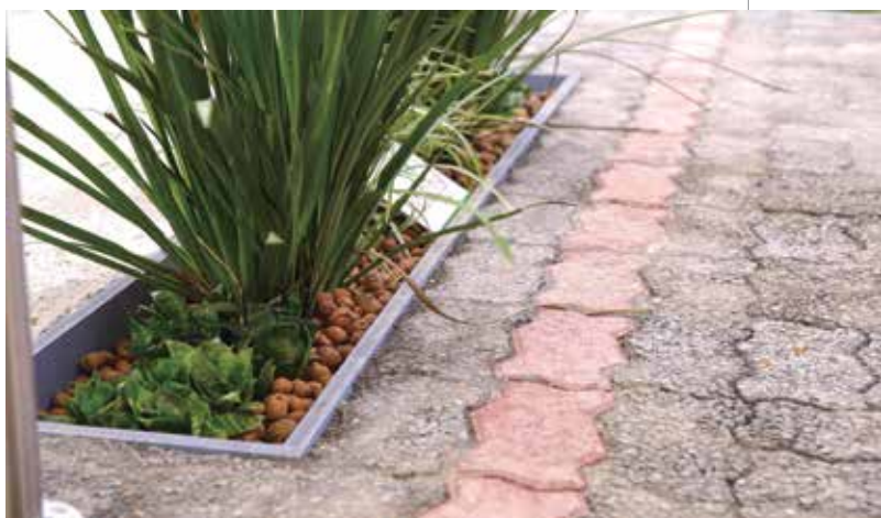
▲ Jardins de chuva ou bacias de infiltração: canteiros em depressão no solo formam bacias para onde é direcionado o escoamento superficial da água da chuva
