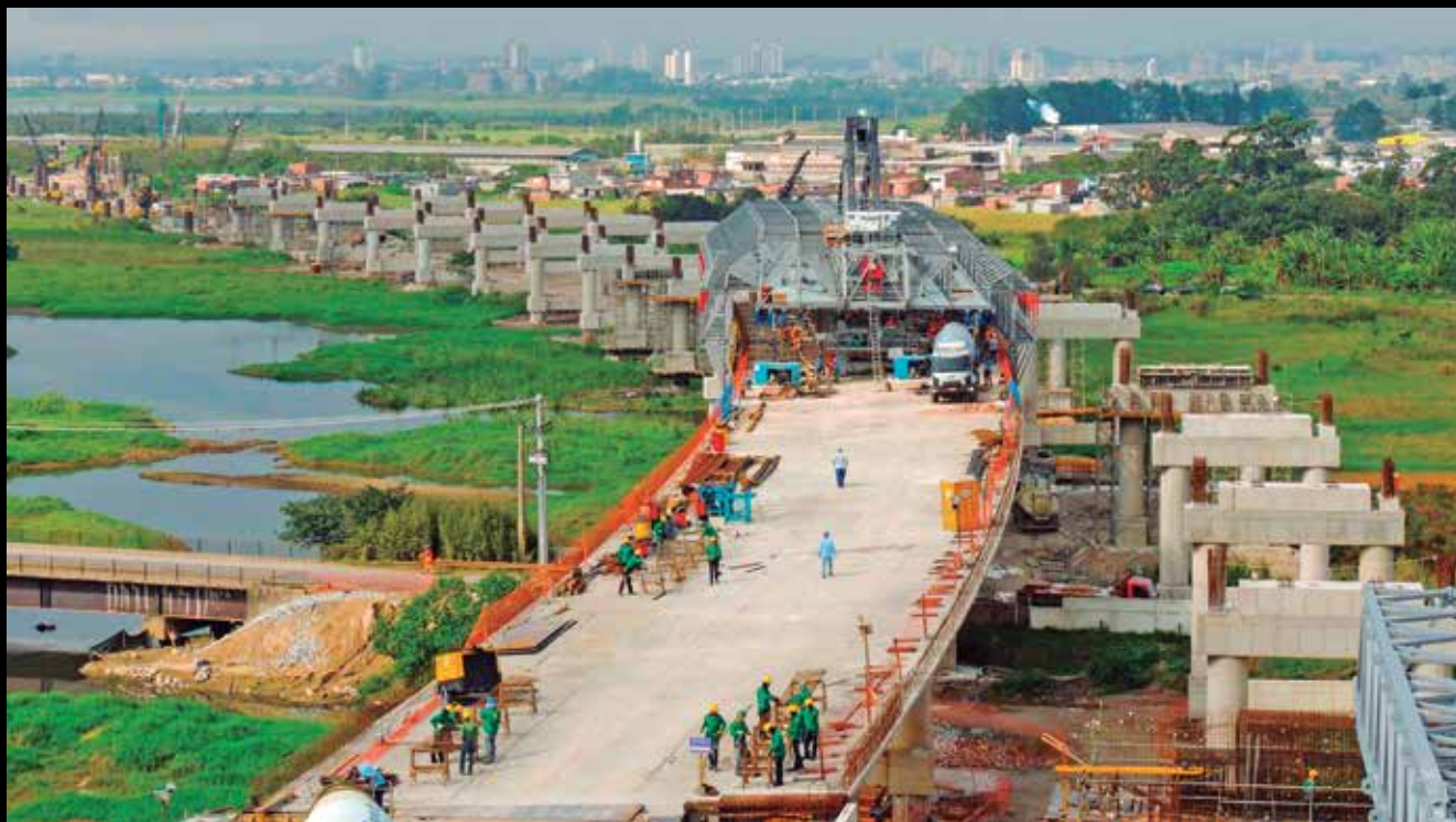
▲ Trecho Leste do Rodoanel – nesse modelo, obra e operação ficaram a cargo do concessionário
