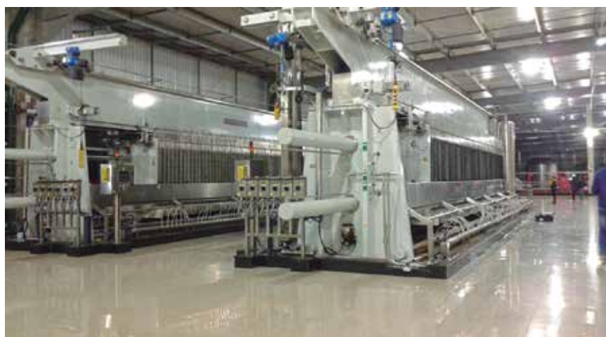
▲ Obra empregou o sistema Light Steel Frame e piso de concreto protendido
