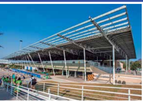
▲ Palco das competições de vela olímpica e paralímpica nos Jogos Rio 2016 a Marina da Glória foi revitalizada com a adoção de estruturas metálicas
