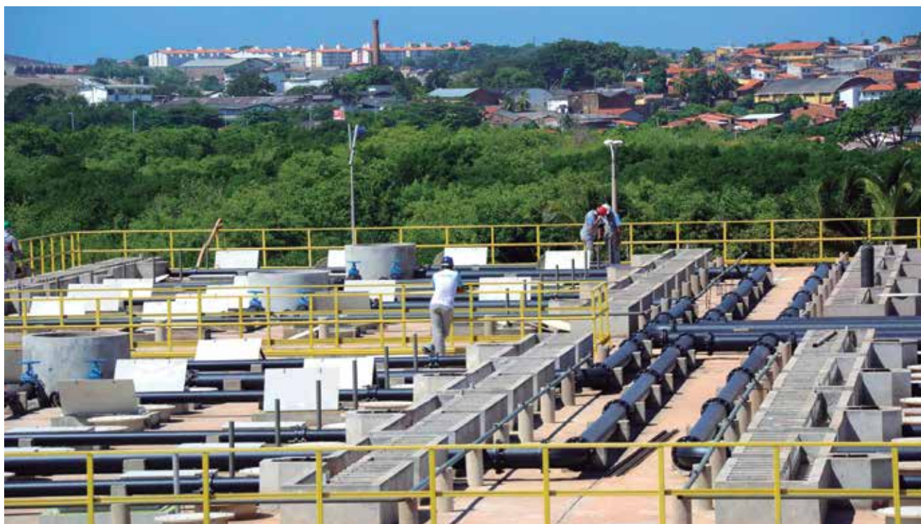
▲ Obras da estação de tratamento de esgotos de Vinhais, para melhoria do saneamento básico na Região Metropolitana de São Luiz (MA)
