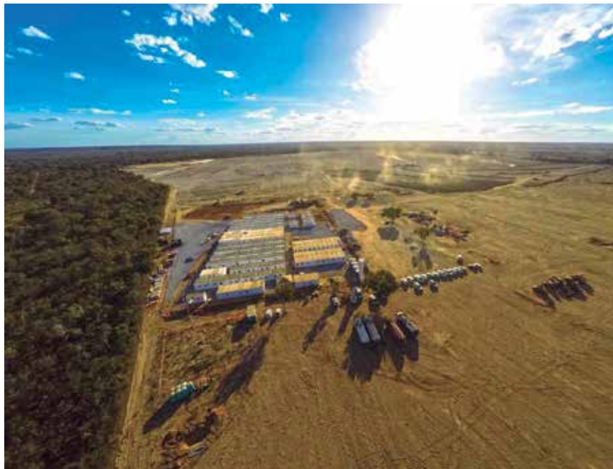
▲ Obras do Complexo Ituverava, em Tabocas do Brejo Velho, no estado da Bahia,
