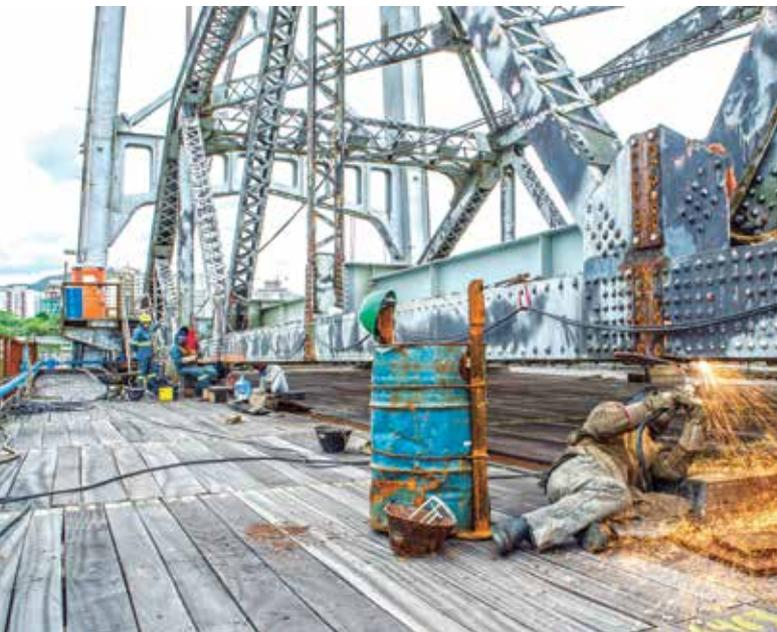
▲ Operação de montagem e soldagem das longarinas entre os alinhamentos
