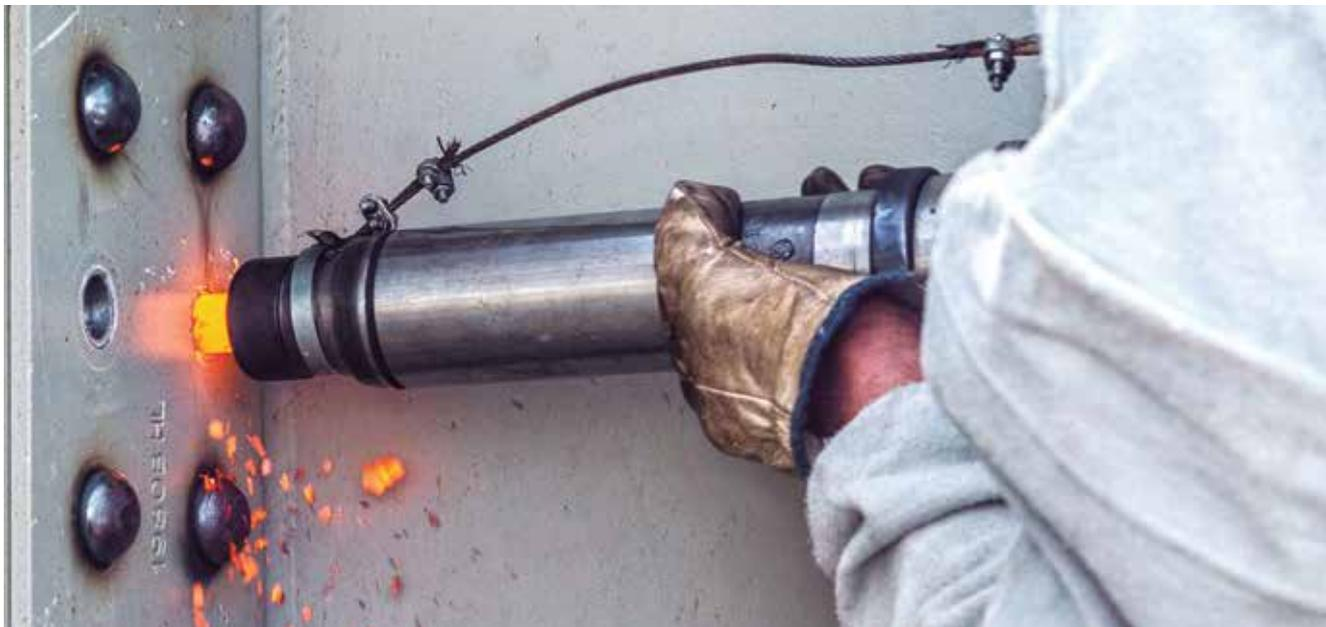
▲ As partes que compõem a estrutura metálica são inicialmente parafusadas e posteriormente rebitadas
