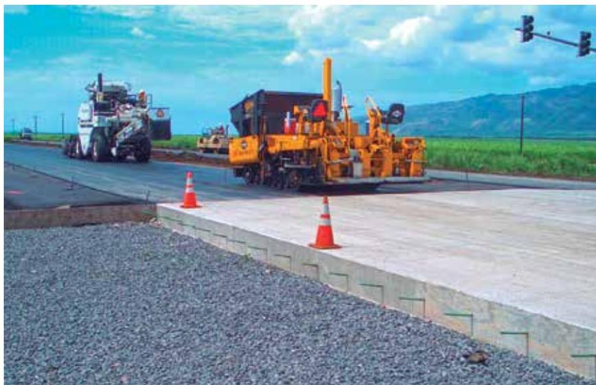
◀ Concreto compactado a rolo em sua aplicação em pavimento rígido de rodovia
