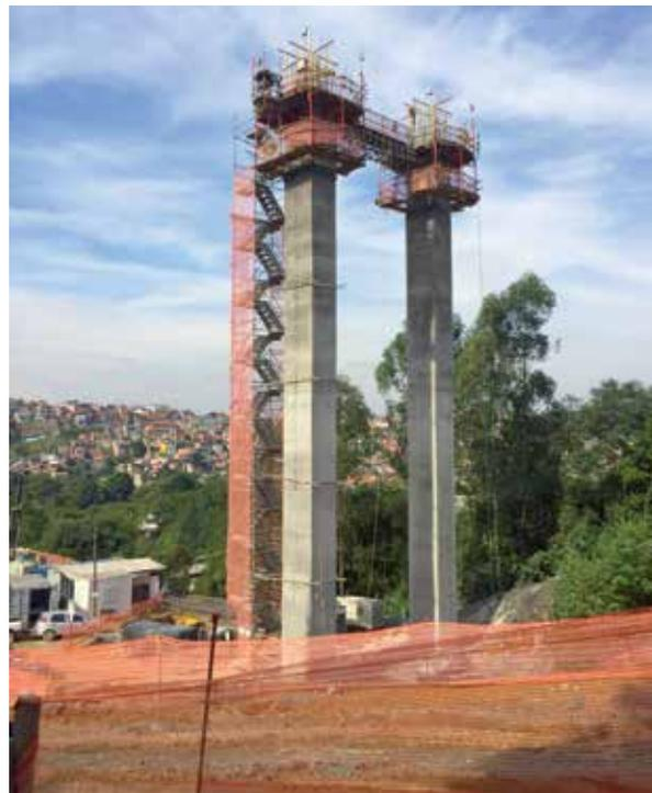
▲ Na execução dos pilares, são utilizadas fôrmas para Pilar Circular SH 1,20m / 1,40m e 1,60m.
