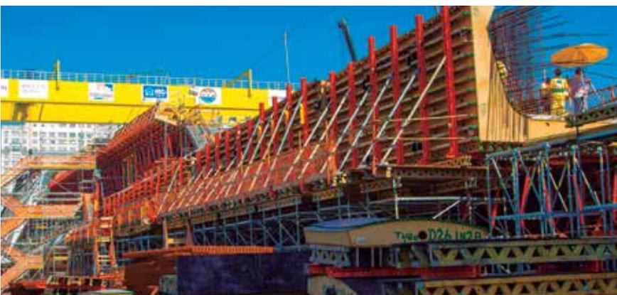
▲ Parte da estrutura metálica foi transportada de navio para o Porto do Rio, pré-montada, em grandes blocos
