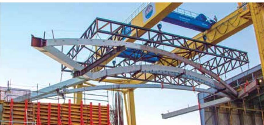
▲ Para a montagem da estrutura foram empregados equipamentos de elevação de carga de grande porte
