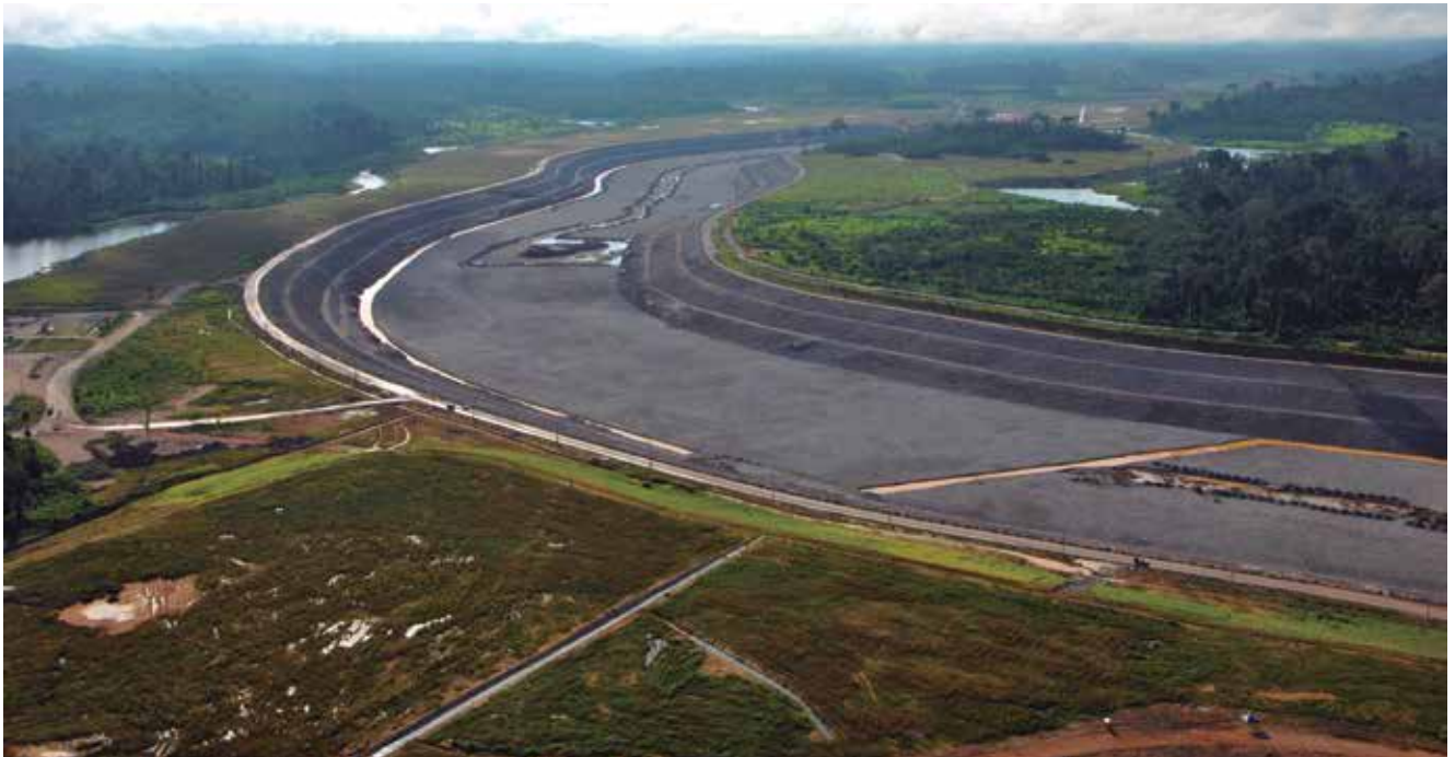
▲ Desvio do rio, obra teve recorde de movimentação de terra
