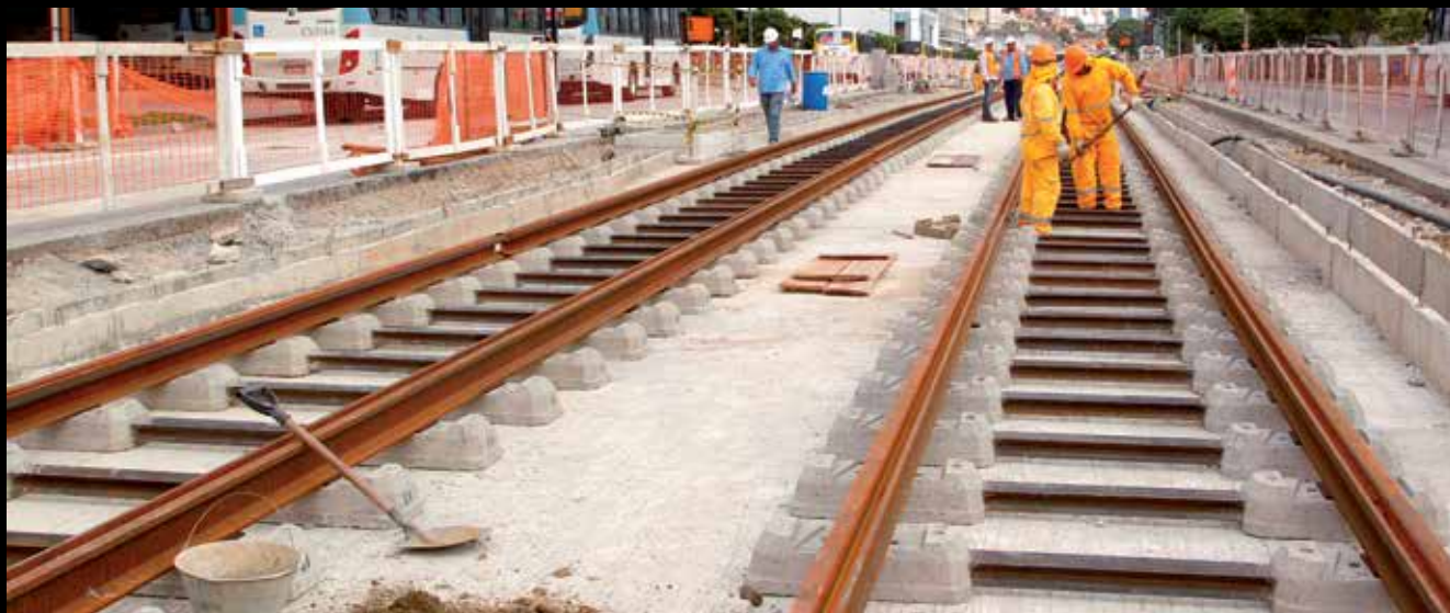
▲ Instalação dos trilhos na via permanente do VLT do Rio de Janeiro, reconhecido com um dos grandes Legados dos Jogos de 2016
