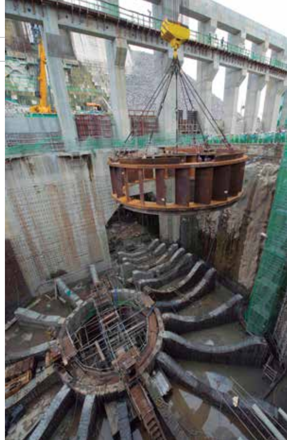
▲ Pontes rolantes usadas na descida do pré-distribuidor do rotor do sítio Belo Monte
