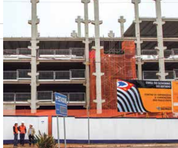
▲ Obras do edifício-garagem, dimensionado para receber 4.500 veículos
