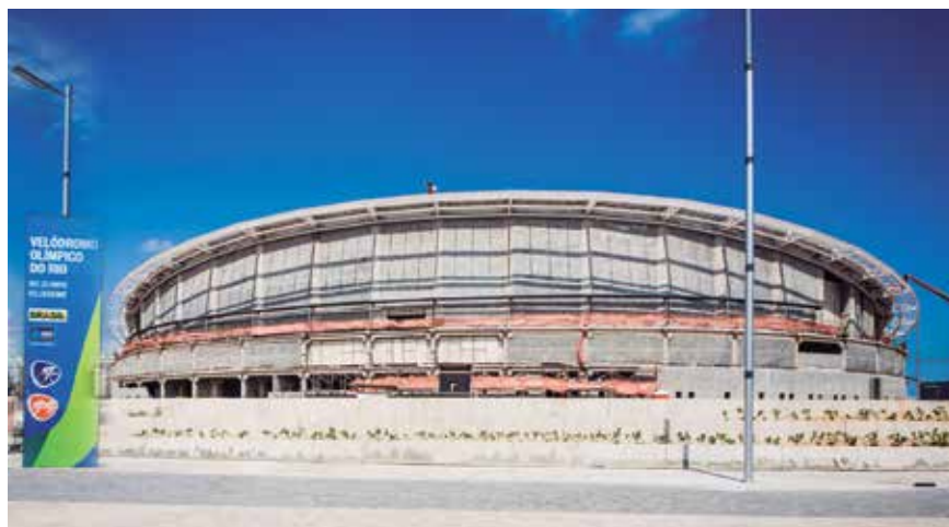
▲ Além de ser a obra mais atrasada, a construção do Velódromo vai ficar R$ 24,8 milhões mais cara em relação ao orçamento original
