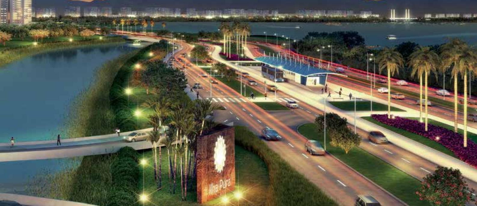
▲ Corredor de BRT Transolímpica, um dos grandes legados para a mobilidade urbana do Rio
