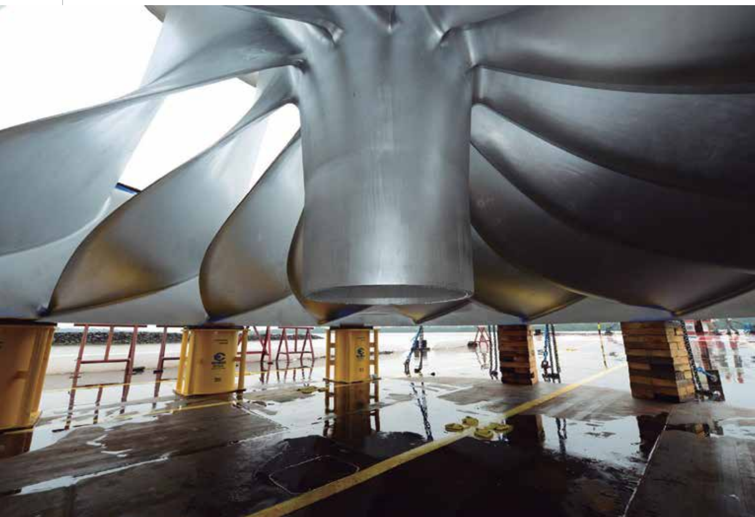
▲ Descida do rotor da turbina da Unidade Geradora 02 da Casa de Força Principal, fabricada pela Voith
