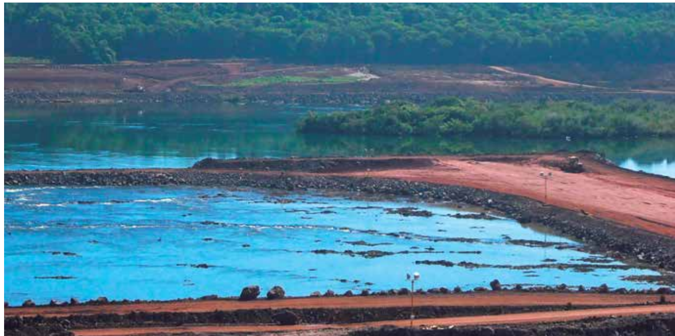
▼ Detalhe da Construção da enseadeira da UHE Baixo Iguaçu
