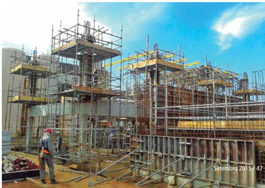
▼ Ampliação usou pré-fabricado em cerca de 70% do empreendimento
