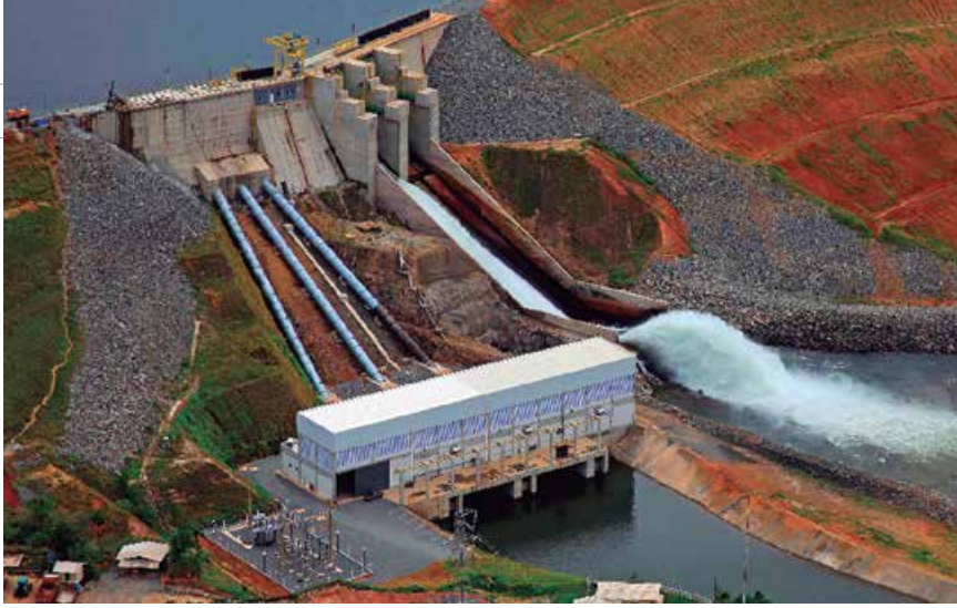
◀ PCH Porto Franco com 30 MW de potência instalada no Rio Palmeiras, em Dianópolis (MA)
