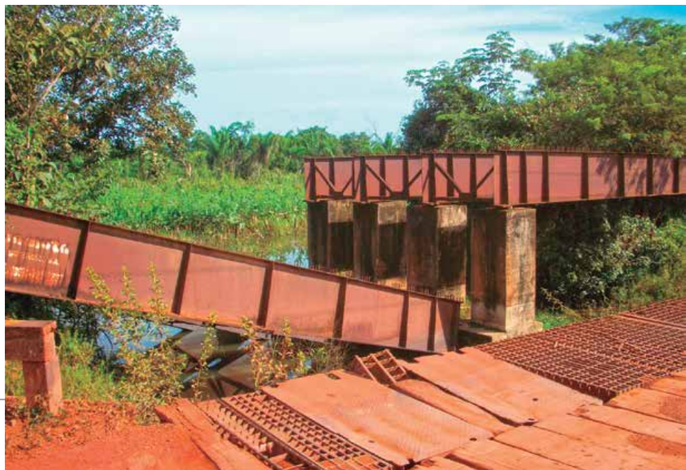
► Ponte no trecho da BR 158 entre Redenção e o distrito de Casa de Tábuas, no Pará
