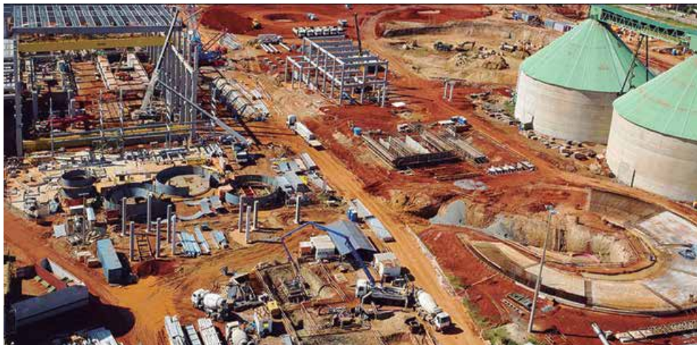
▲ Concretagem das bases das turbinas do turbogerador exigiu estudos elaborados devido ao grande volume de concreto
