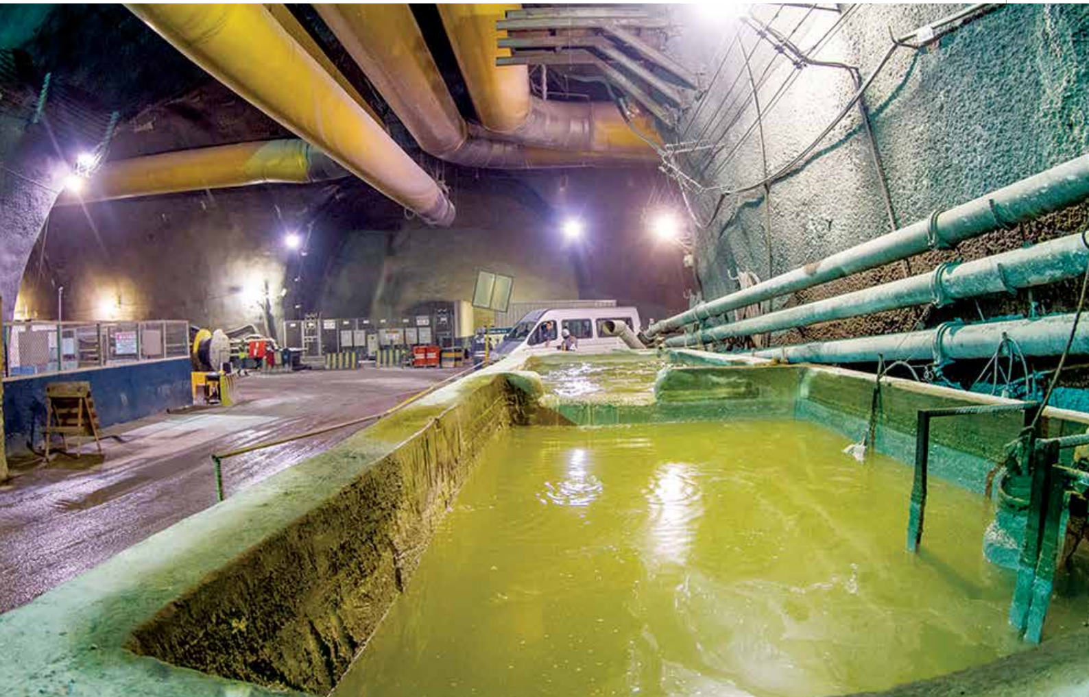
▲ Obras da Linha 2: água utilizada no processo de escavação dos túneis é totalmente tratada e reutilizada no processo de construção
