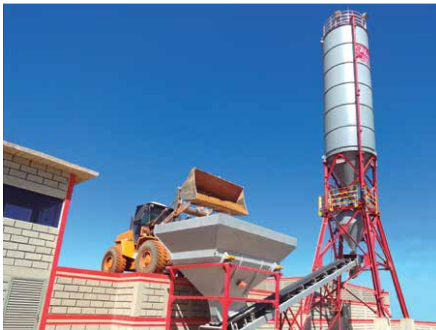
▲ Perspectivas conservadoras: as vendas de centrais de concreto não devem superar as 40 unidades em 2015
