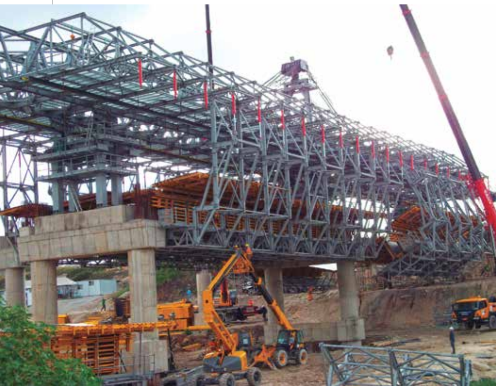
◀ No Cimbramento Móvel uma estrutura de aço dá suporte à fôrma para colocação do concreto armado
