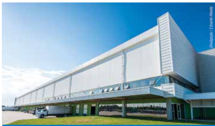
Centro de Distribuição Grupo Boticário
