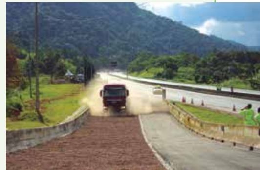
Viaduto (Com Alças) - km 646+050 BR-376/PR
