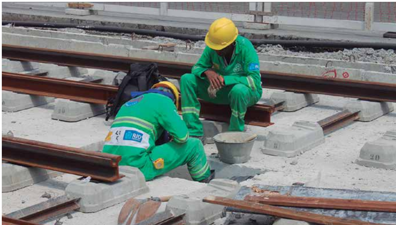
▲ Já foi instalado cerca de meio quilômetro de trilhos do sistema do VLT do Rio de Janeiro
