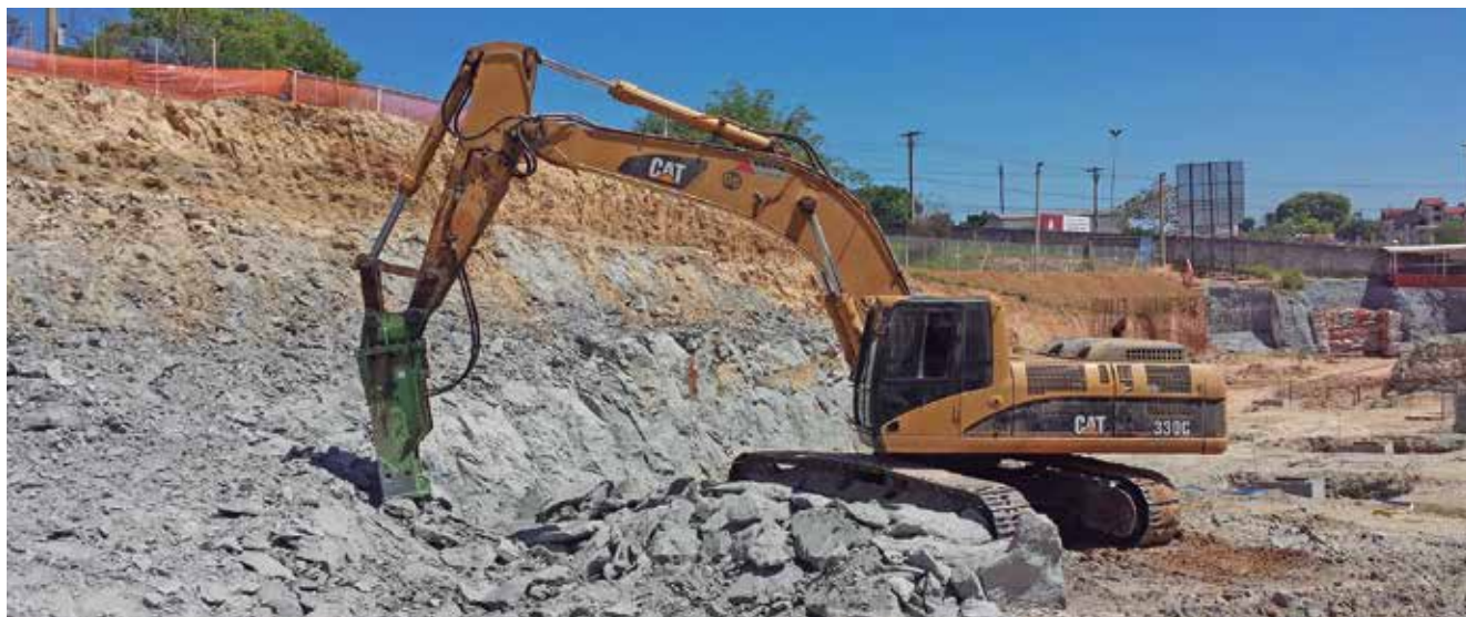
▲ A obra está com 70% da escavação e 35% das sapatas e contenções concluídas
