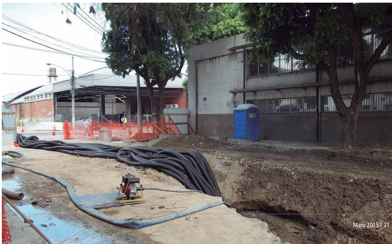
▼ Toda a malha de infraestrutura está sendo enterrada, acabando de vez com os postes de concreto nas calçadas da região
