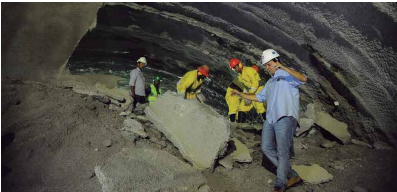
▲ Prefeito do Rio, Eduardo Paes, visita as obras do Túnel Rio450
