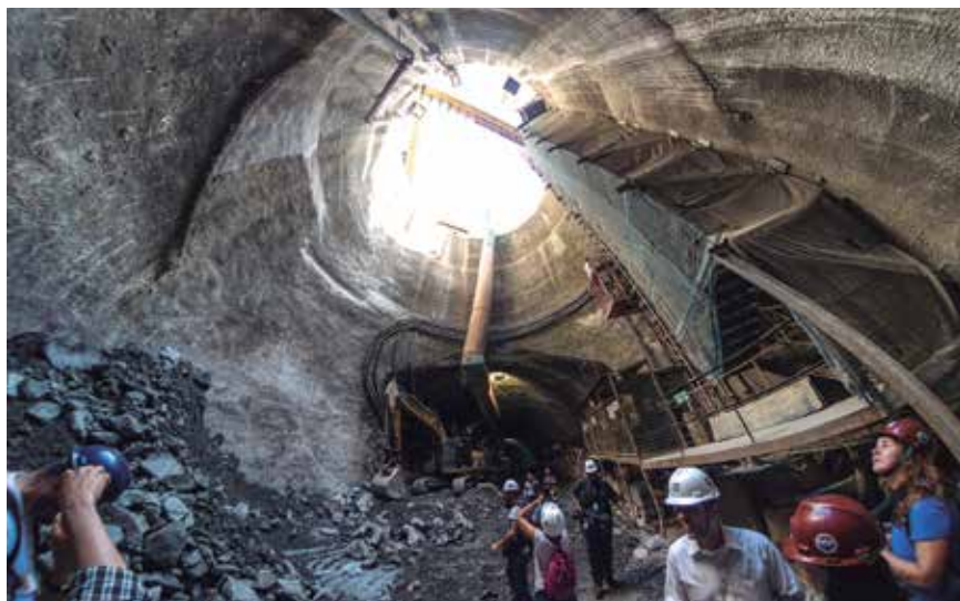
▲ Poço de serviço da Avenida Venezuela, perfurado para facilitar as obras do Túnel Rio 450.
