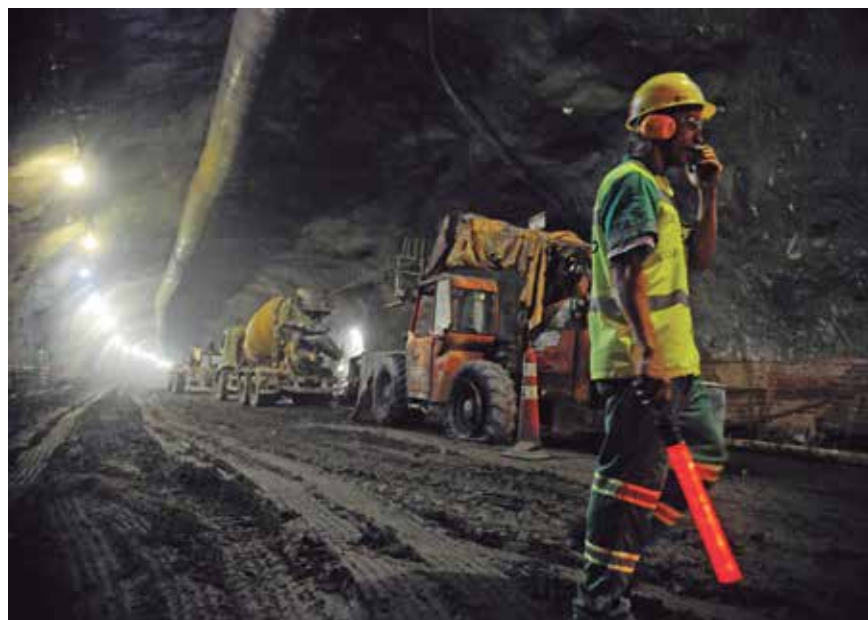
► Durante o primeiro mês de operação, o Túnel Rio450 deu passagem a 373.337 veículos
