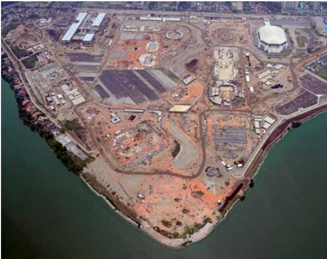
▲ Obras do Parque Olímpico do Rio de Janeiro, na Barra da Tijuca
