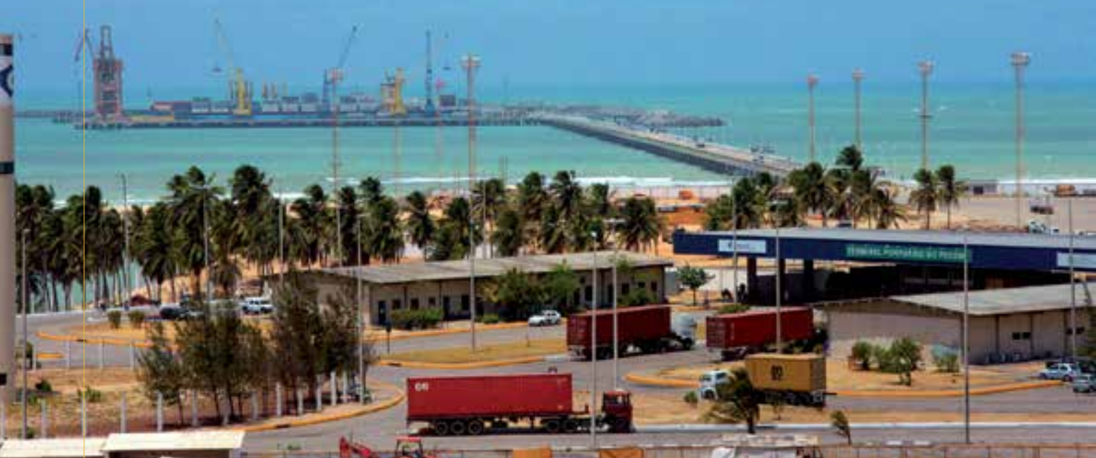
▲ Usina Termelétrica de Pecém, situada no Complexo Industrial e Portuário do Pecém (CIPP)
