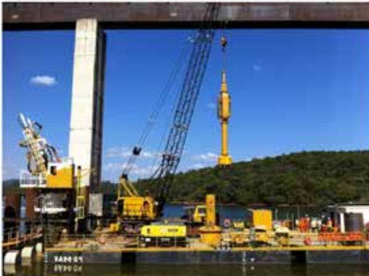
( Foto: Ponte Ferroviária sobre o Rio Petti em Barão dos Cocais/ MG )
