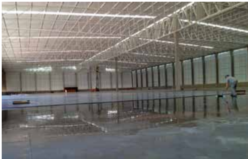
◀ Macrofibras de Polipropileno estão sendo agregadas ao concreto em pisos industriais, com excelentes resultados
