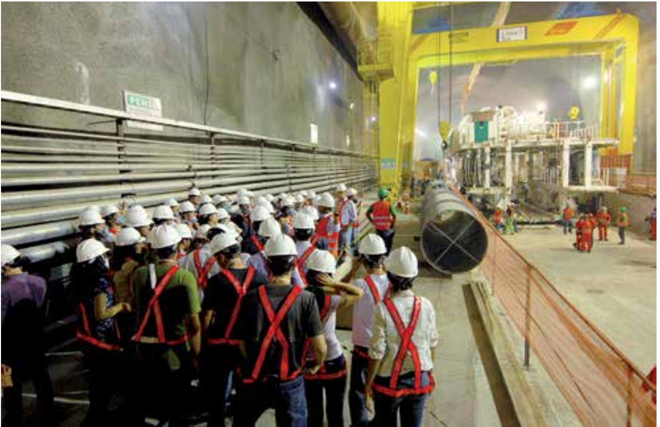
▲ Obras da Linha 4 do Metrô do Rio de Janeiro, principal obra de mobilidade e legado dos Jogos Olímpicos de 2016
