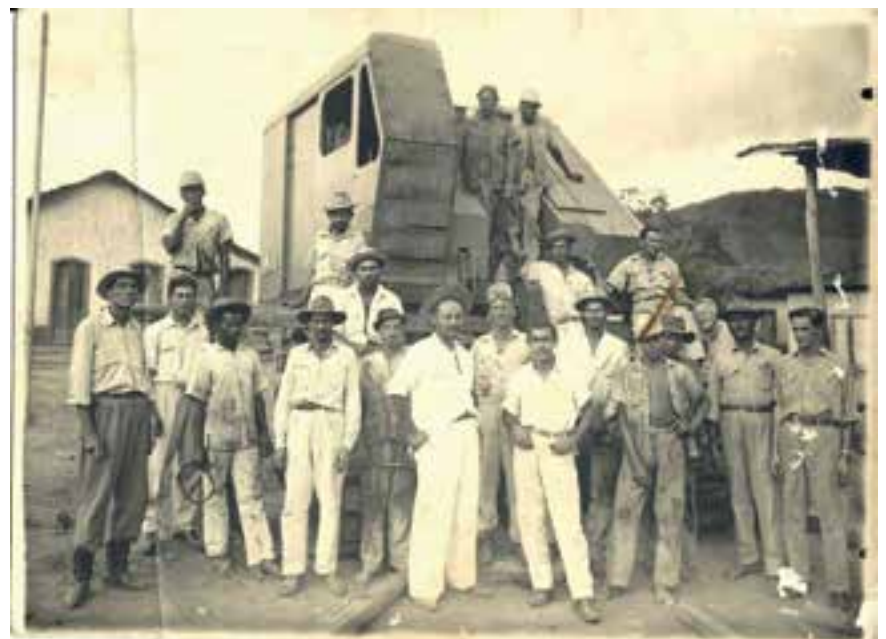
► Foto histórica mostra operários que atuaram na construção da Estrada de Ferro Mapele-Passagem
