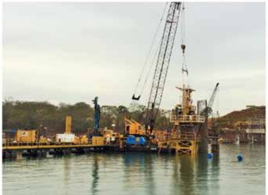
( Foto: Ponte Ferroviária sobre o Rio Grande em Iturama/ MG )
