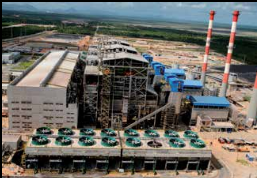
◀ Obras de instalação da Companhia Siderúrgica do Pecém - CSP 1, na área de influência do porto
