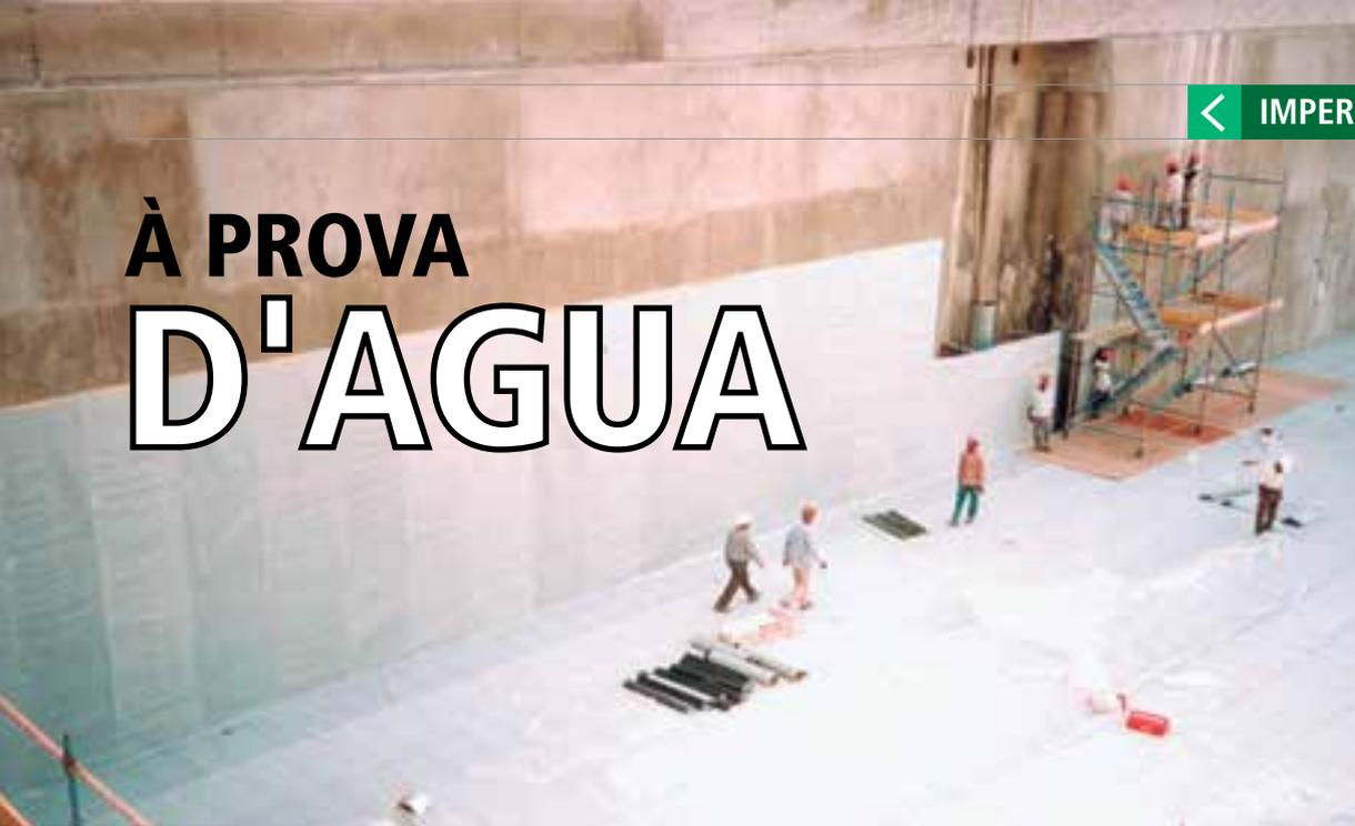
◀ Utilização de manta impermeabilizante em grandes estruturas de concreto garante elevada resistência à água, gases e vapores do solo
