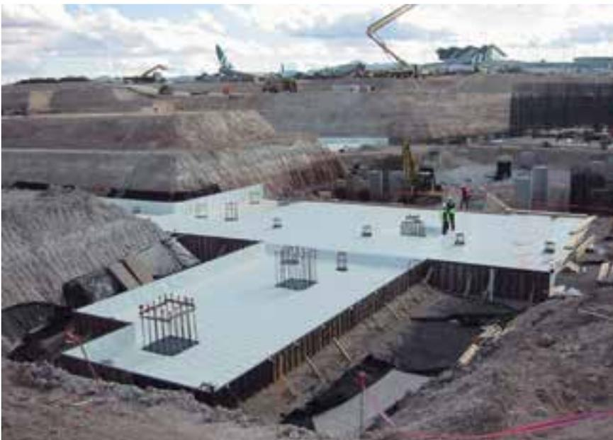
salinidade, toda a estrutura de concreto foi revestida por uma manta especial impermeabilizante, fornecida e aplicada pela Grace Construction Products.
