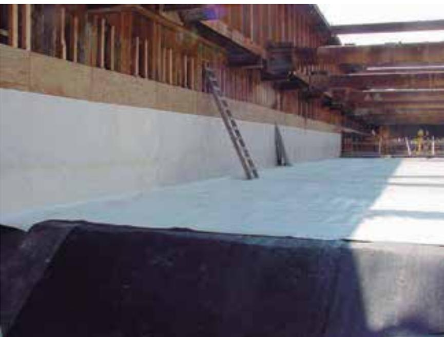
◀ A manta impermeabilizante é colocada sobre o substrato, permitindo, logo em seguida, a confecção das armaduras de lajes e paredes
