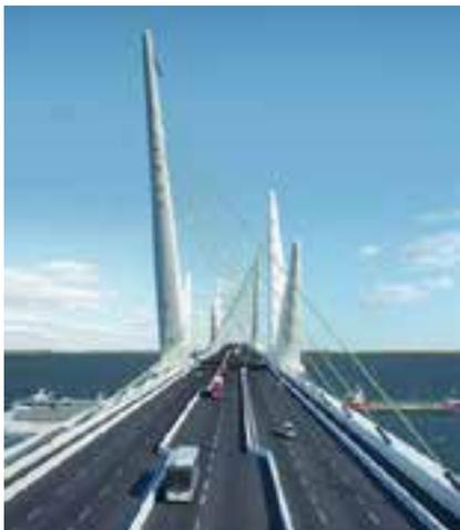
◀ Detalhe do trecho estaiado, com 70 m de altura e 25 m de profundidade
