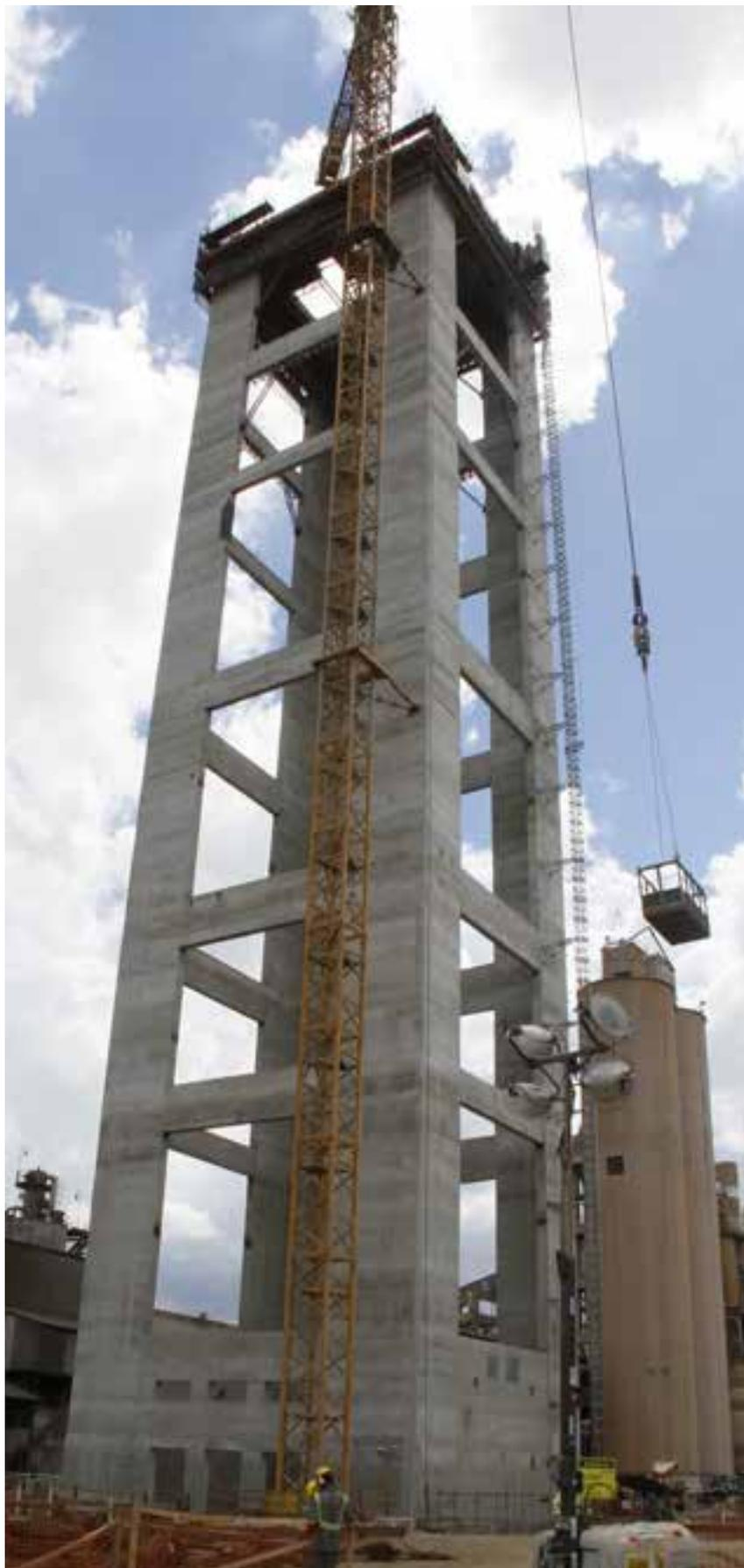
◀ Conclusão do deslizamento da fôrma da torre do pré-aquecedor
