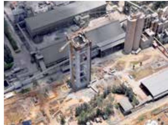
▲ Conclusão do deslizamento da fôrma da torre do pré-aquecedor
