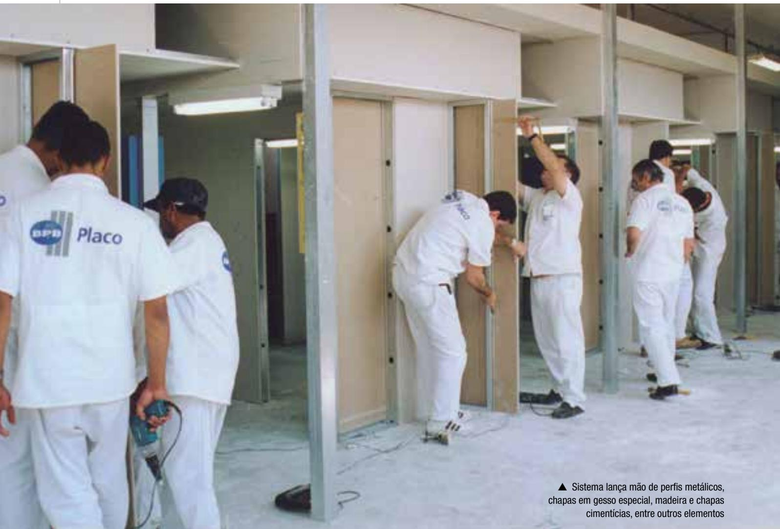
▲ Sistema lança mão de perfis metálicos, chapas em gesso especial, madeira e chapas cimentícias, entre outros elementos
