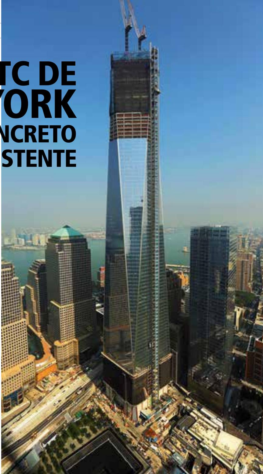
▲ World Trade Center, com 541 metros de altura, foi construído com concreto ultrarresistente e especialmente personalizado
