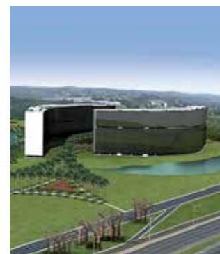
Cidade Administrativa - BH
