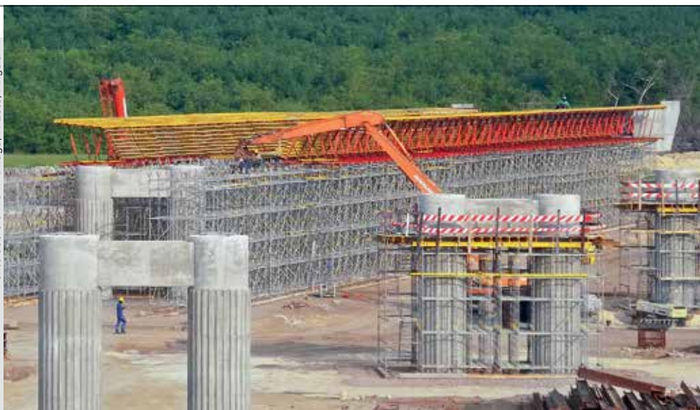
Ponte sobre o Rio M Bridge, N'Zeto, Angola
