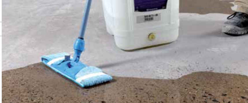
▲ Aplicação do sistema Hiperfloor, realizado por meio do Husqvarna Hiperhard, aumenta a resistência à abrasão do piso, permitindo que ele seja polido novamente sempre que necessário
