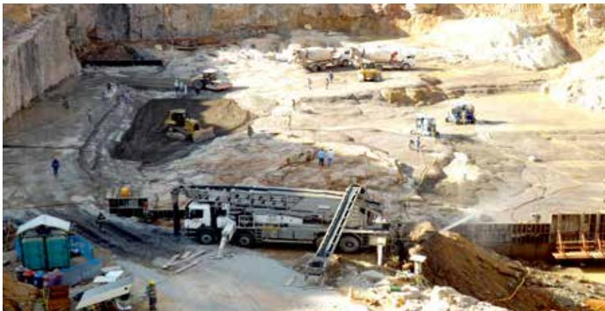
▲ Barramento, vertedouro, lançamento de CCV (regularização) e de CCR (maciço de restituição)
