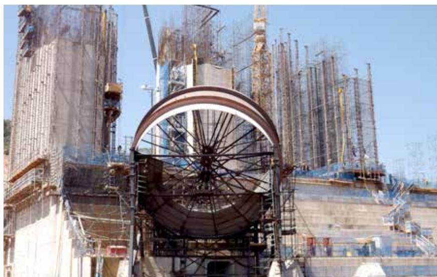
▶ Condutos forçados, lançamento das virolas 121 e 122 no bloco de ancoragem superior
