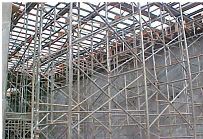
Escoramento com Torre "JX" e Vigas VF5" e VF3"
