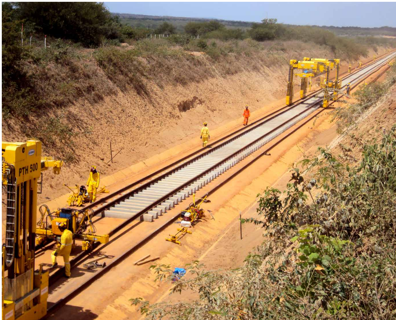
▲ Construção de ferrovias no Brasil depende da importação de vários itens, como os trilhos
