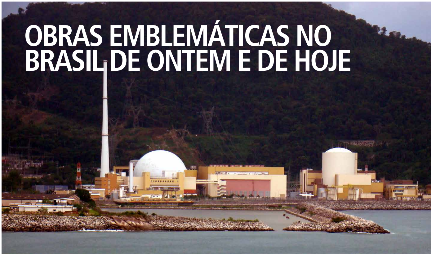
▲ Angra 1 e Angra 2, construídas na década de 1980 - o Brasil entra na era nuclear
