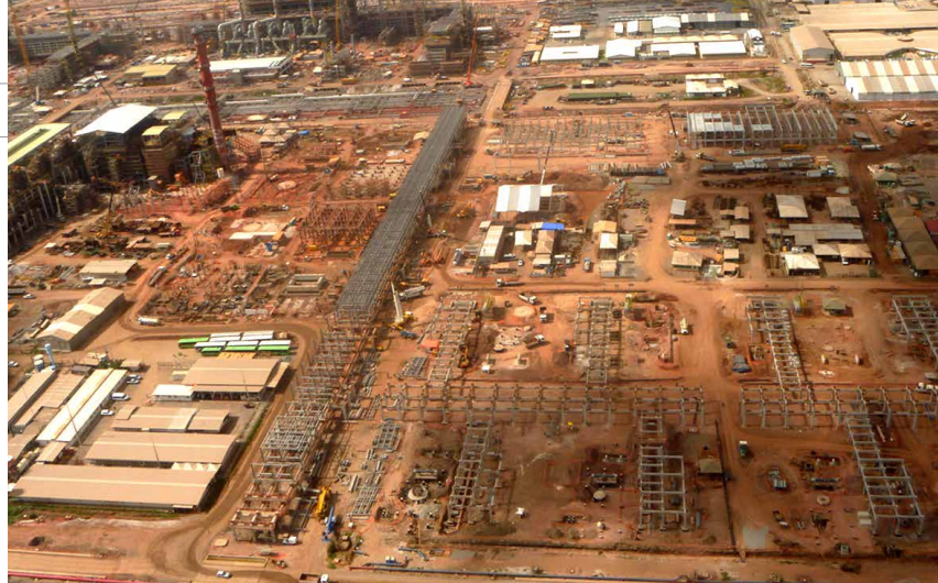
▲ Primeira refinaria totalmente construída com tecnologia nacional
