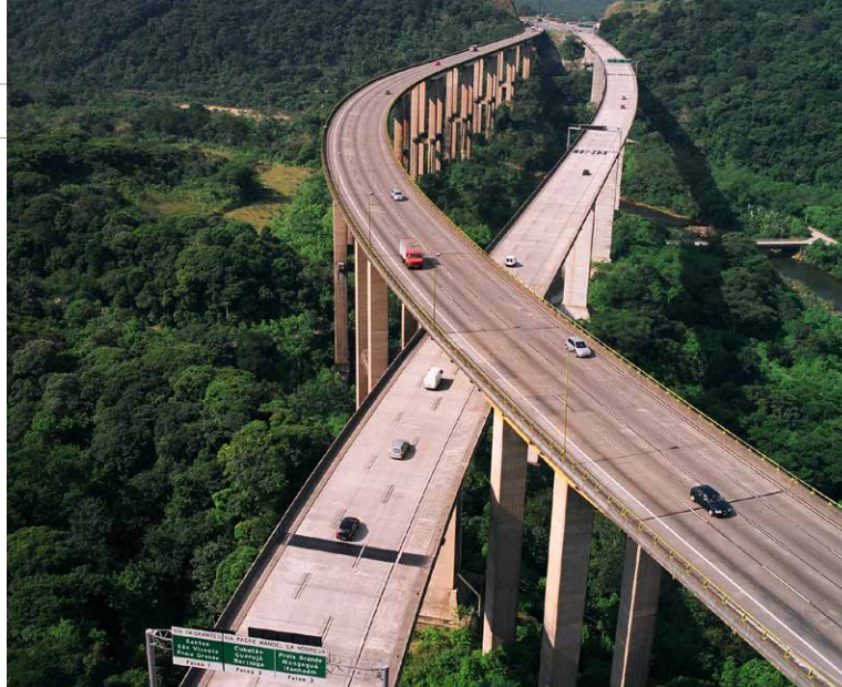
▲ Segunda pista da Rodovia dos Imigrantes, concluída em 2002 – obra simboliza nova etapa de concessões rodoviárias no estado e é considerada referência internacional, devido aos projetos e mecanismos empregados para reduzir o custo ambiental
