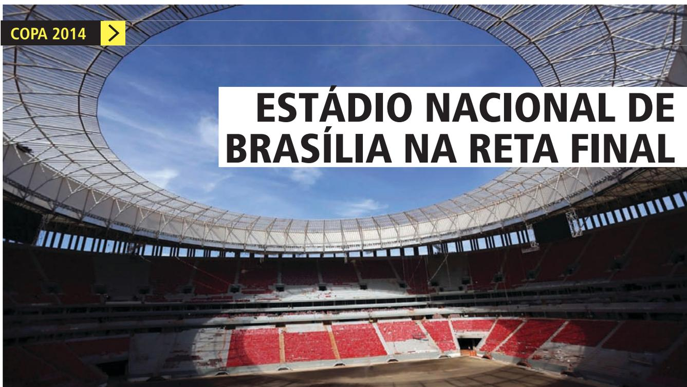
Placas de policarbonato, Makrolon UV 2099, produzidas pela Bayer, garantem proteção da chuva e sol forte e proporciona leveza no visual arrojado da estrutura interna da cobertura
