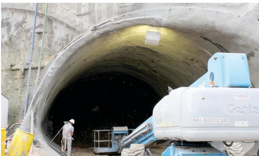
▲ Detalhe das obras no emboque dos Túneis sob o Morro da Saúde, escavados com o emprego de detonações controladas
