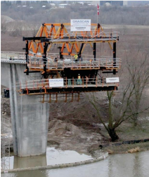
▲ Sistema de balanço sucessivo é indicado para transportar áreas alagadas ou de intensa movimentação urbana
