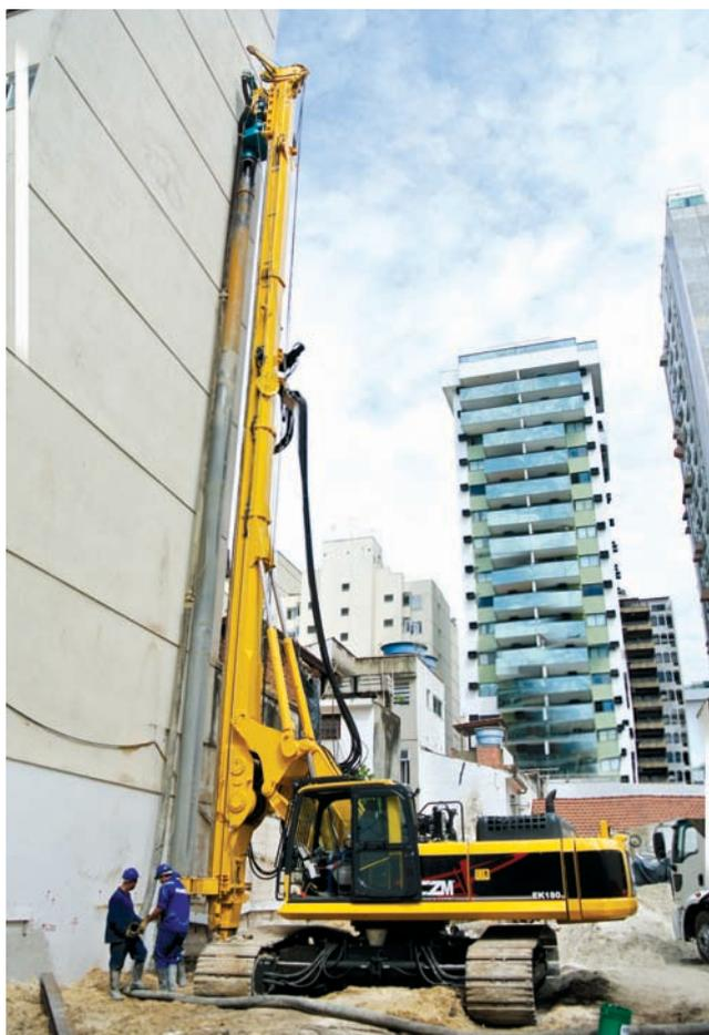
Empresa provedora de soluções inteligentes em equipamentos para fundação, a CZM Indústria de Equipamentos Ltda. está preparando uma série de novidades para apresentar. Entre elas está a estaca hélice entubada modelo EK180ES, que executa paredes diafragmas mediante a perfuração de estacas secantes. Esse método conjuga a produtividade de hélices contínuas com a segurança do revestimento de estacas tipo raiz e se diferencia dos métodos tradicionais por ser rápido, limpo e
