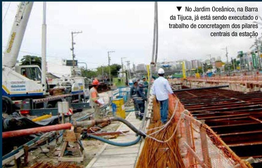
▼ No Jardim Oceânico, na Barra da Tijuca, já está sendo executado o trabalho de concretagem dos pilares centrais da estação
