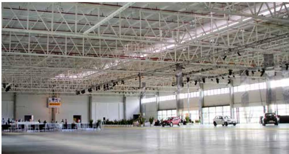
▲ No interior do prédio vê-se o vão livre da cobertura, com extensão de 50 m, executada em treliças metálicas.
