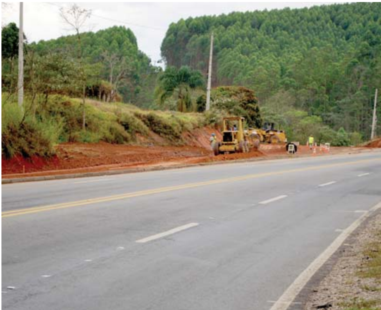
▲ Nova Tamoios: obras acontecem com rodovia em operação
