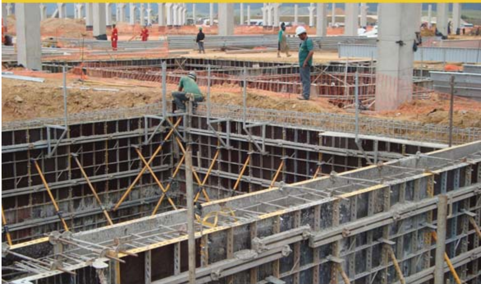
FÔRMA PORTÁTIL COMAIN - FÁBRICA HYUNDAI - ITATIAIA - RJ
