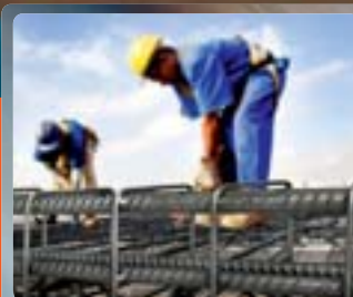
Corte e Dobra de Vergalhões e Armadura Pronta
