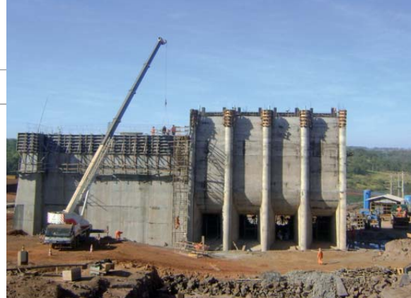
▲ Construção da PCH de Queixada, em Goiás
