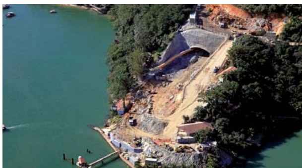
▲ Saída do túnel de ligação entre o píer e o pátio de armazenamento de minério, cujas obras foram concluídas no fim do ano passado
