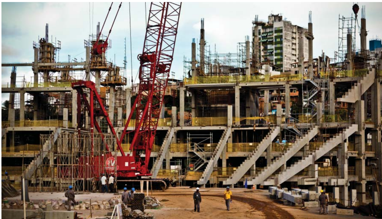
▲ Obras da Nova Fonte Nova, umas das financiadas pelo programa BNDES ProCopa Arenas
