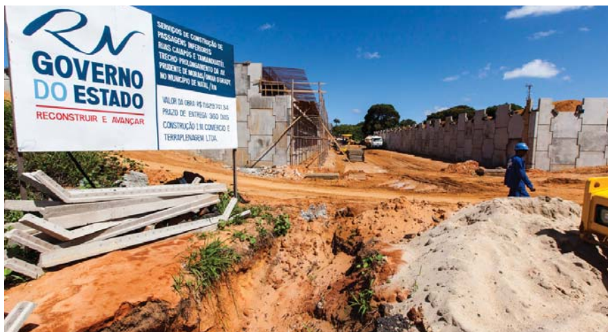
▲ Obras de requalificação do sistema viário de Natal (RN): falta licença ambiental para a construção de duas avenidas de acesso ao estádio causou atrasos no cronograma
