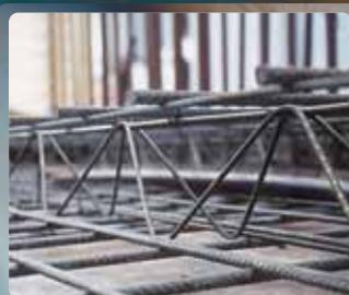
Tela Soldada Nervurada e Espaçador Treliçado
