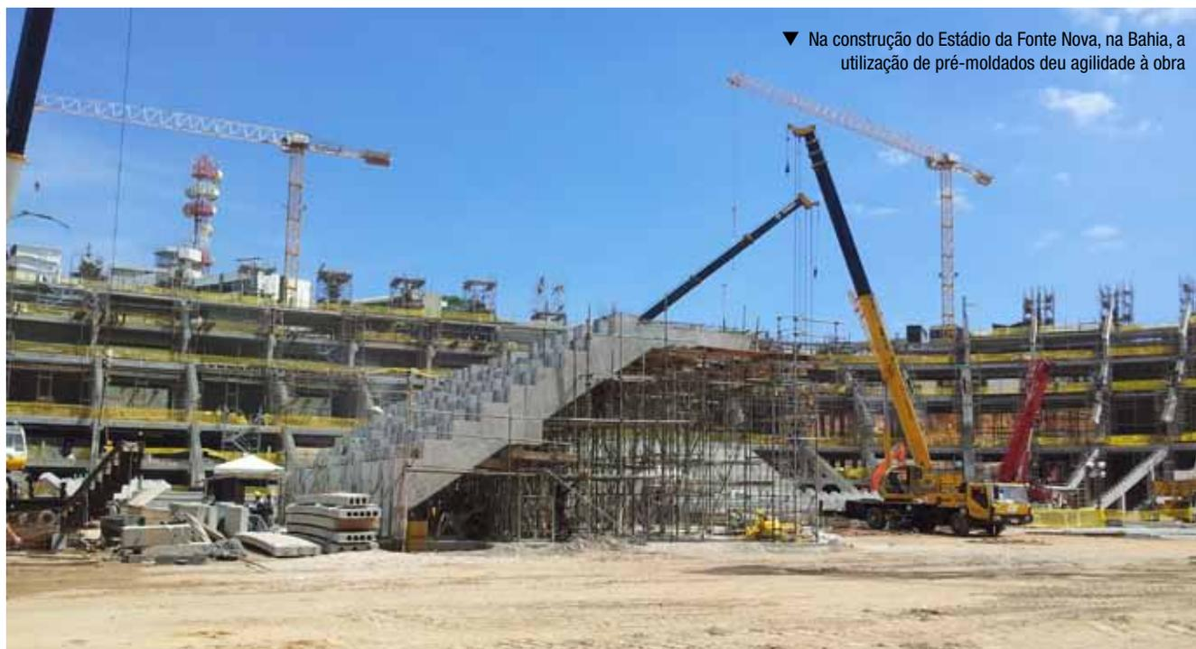
▼ Na construção do Estádio da Fonte Nova, na Bahia, a utilização de pré-moldados deu agilidade à obra
