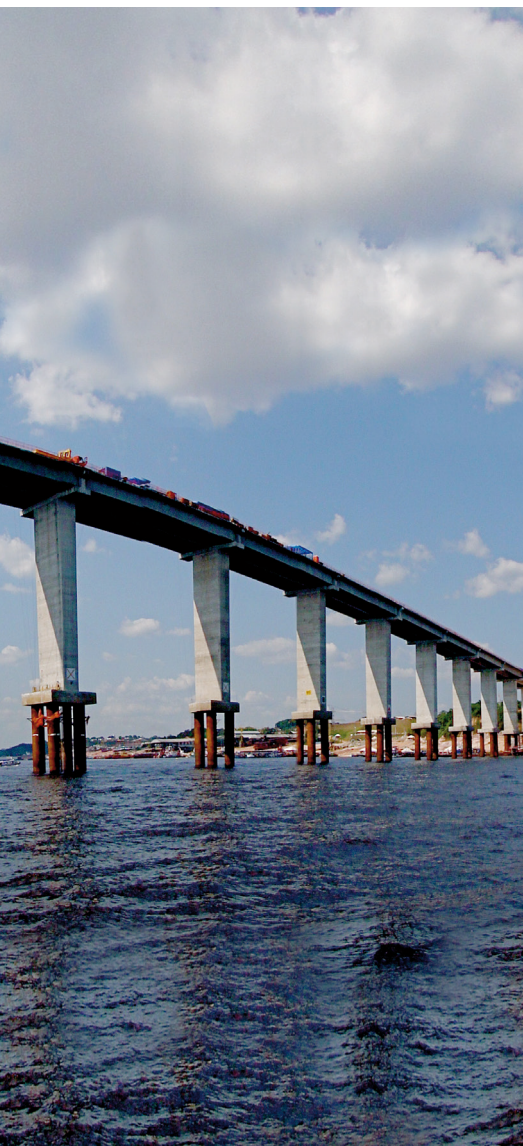
◀ Ponte sobre o Rio Negro, no Amazonas, de 3,6 km de extensão: estrutura de aço e concreto protendido
