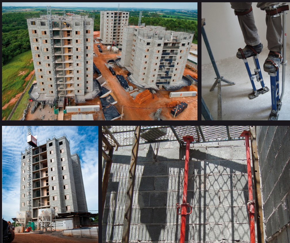
▲ Construtora Alavanca investe em equipamentos modernos com foco na agilidade dos processos e na segurança
