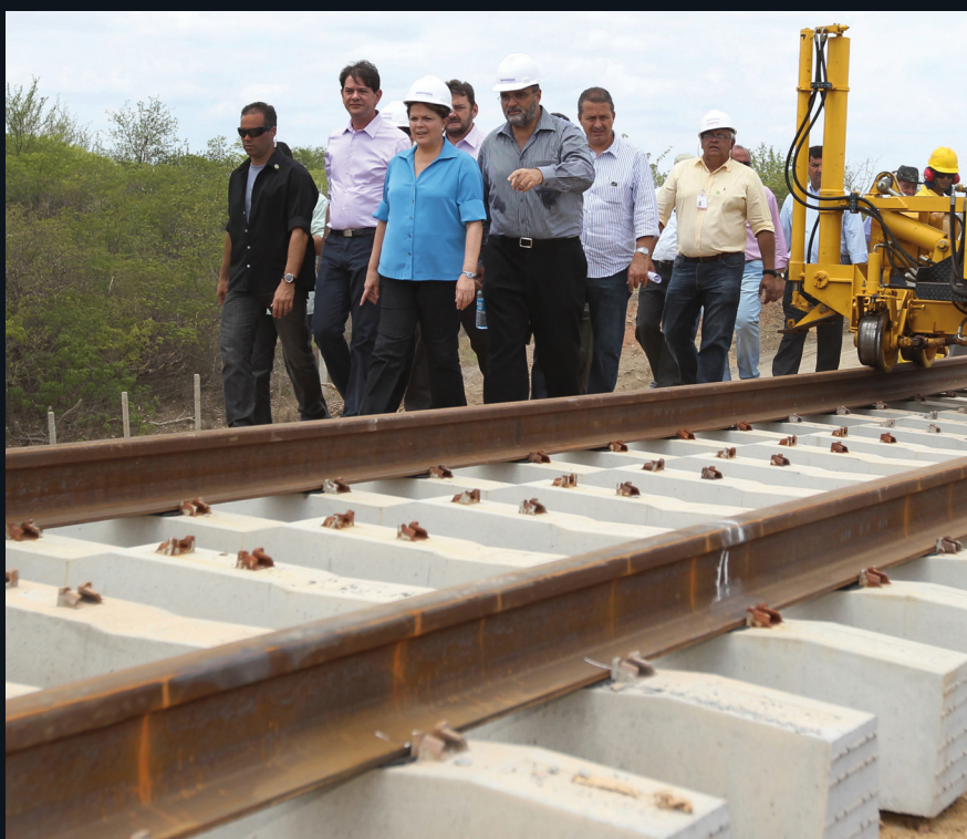
▶ Presidente Dilma Rousseff visita as obras da Transnordestina, em trecho no estado de Pernambuco
