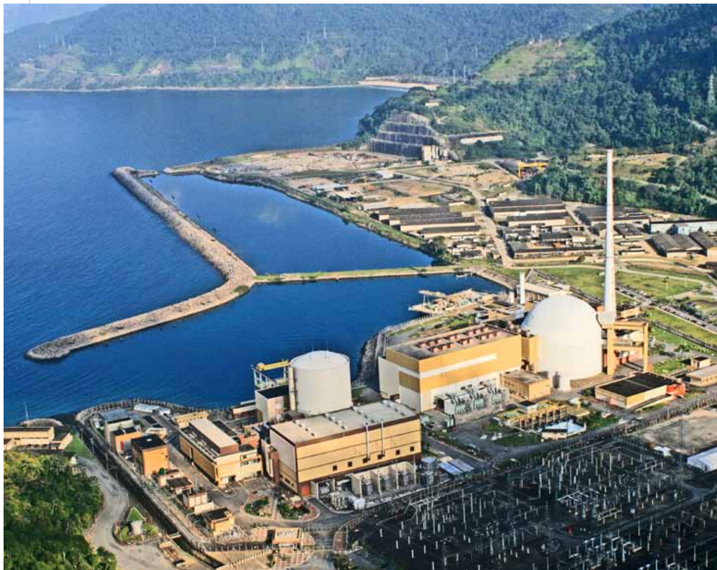
▲ Na parte superior da foto, o canteiro de obras da usina Angra 3
