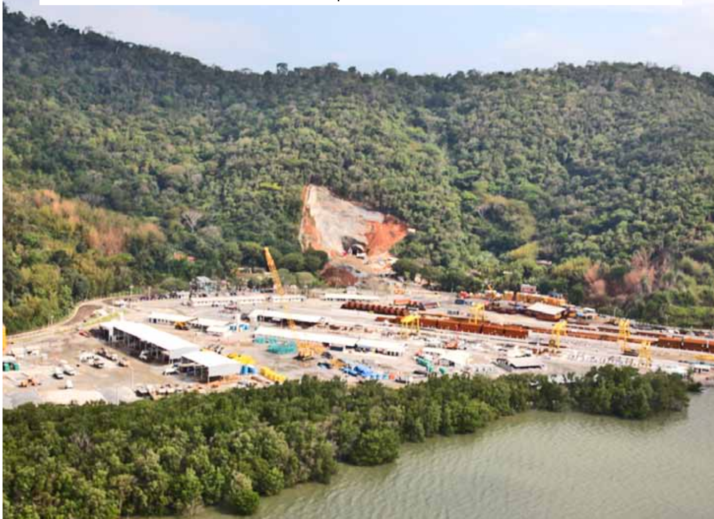
▲ Canteiro de obras da infraestrutura da área sul das futuras instalações da Base Naval Norte
