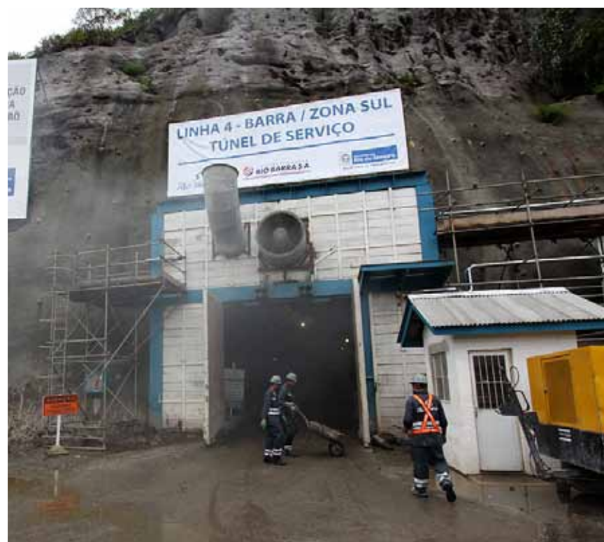
► Operários em atividade na entrada do túnel de serviço, no Jardim Oceânico
