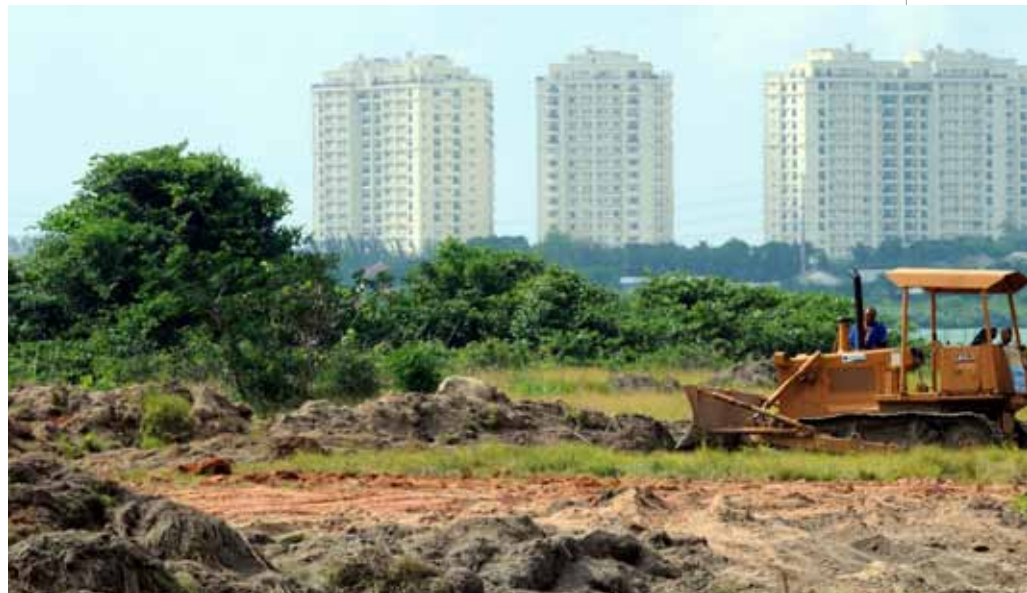
▲ Início das obras de terraplanagem em terreno onde foi instalado o Parque dos Atletas
