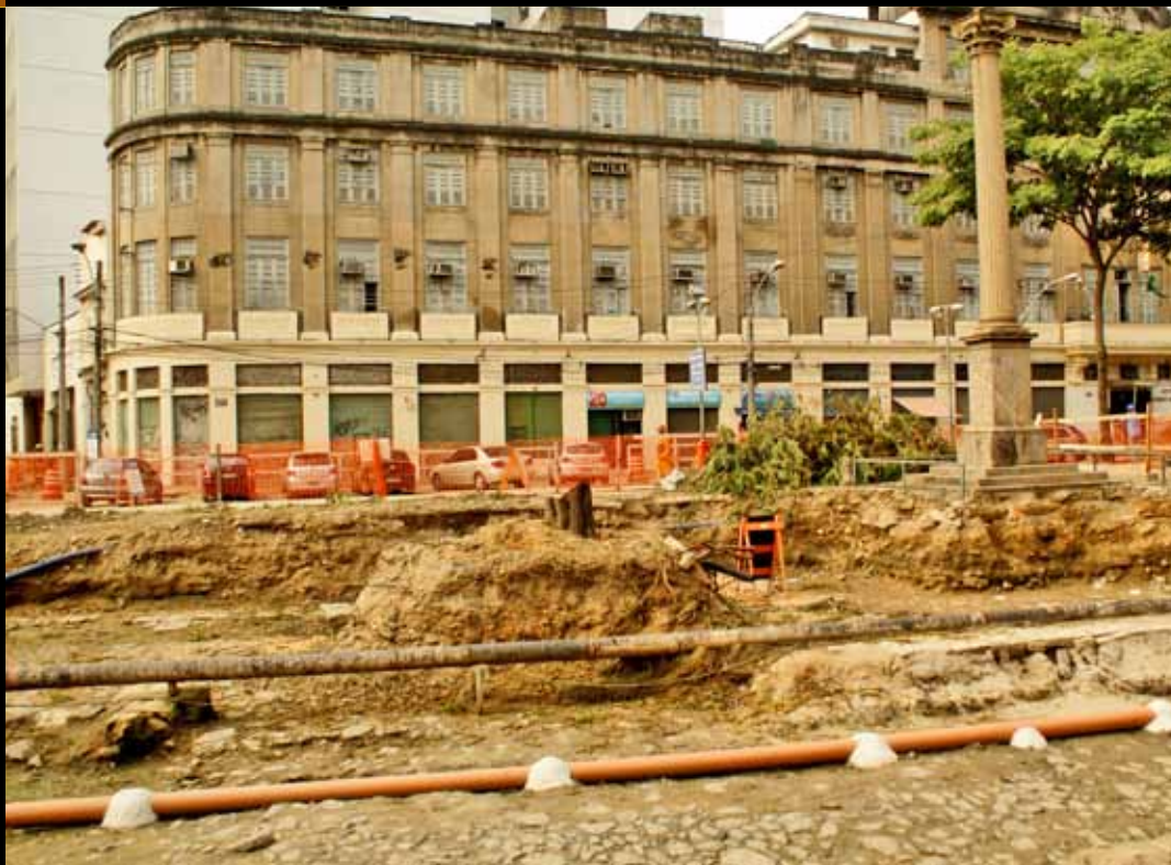
► Obra de infraestrutura de saneamento na área do Porto Maravilha
