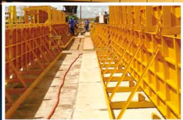
Fôrmas para arquibancada - Arena de Brasília Consórcio Brasília 2014
