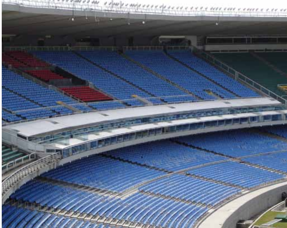
▲ Estádio receberá cobertura de membrana tensionada sustentada por cabos de aço
