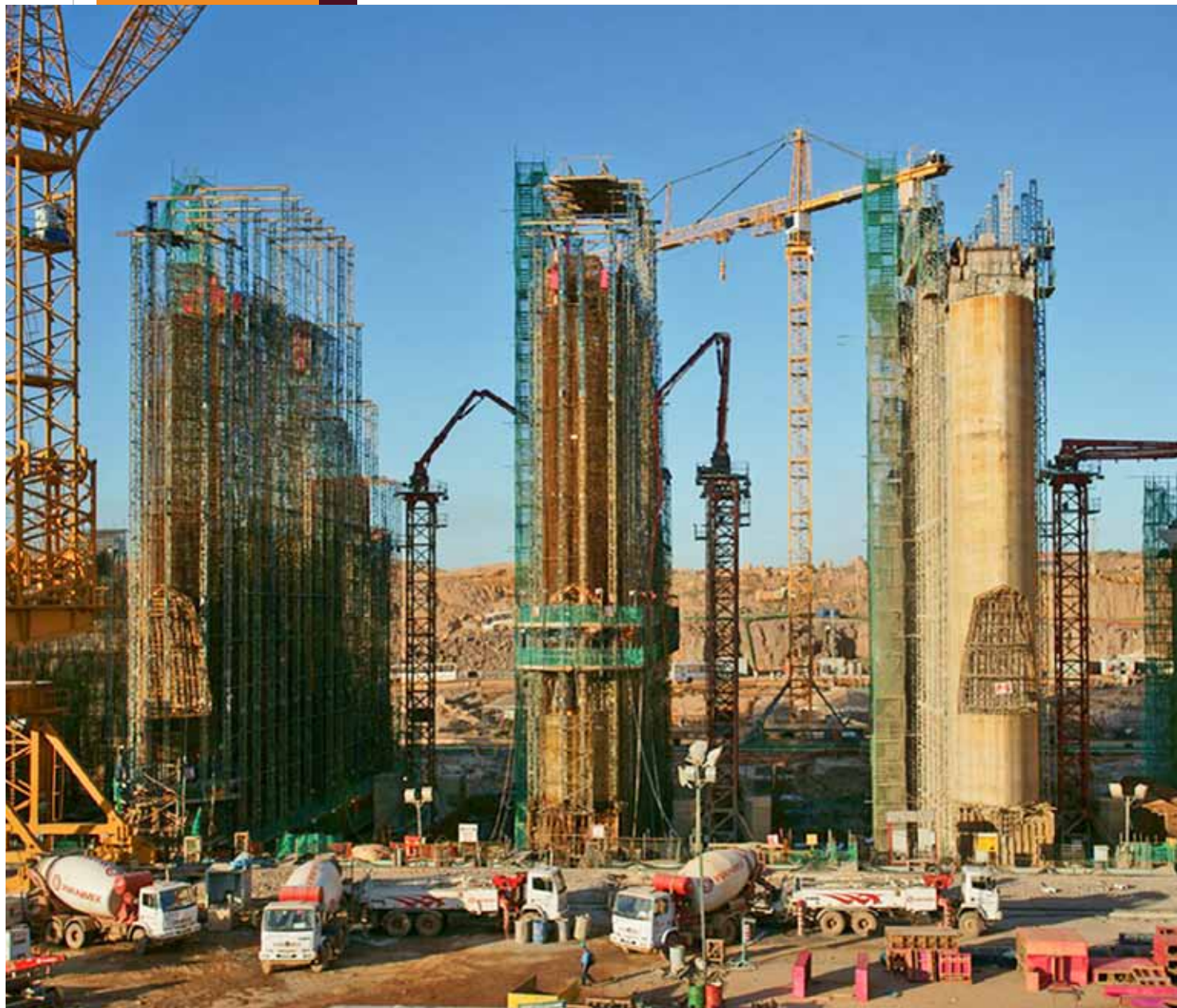
▲ Obras da Hidrelétrica de Santo Antônio, do Complexo do Rio Madeira, com previsão de conclusão para 2015
