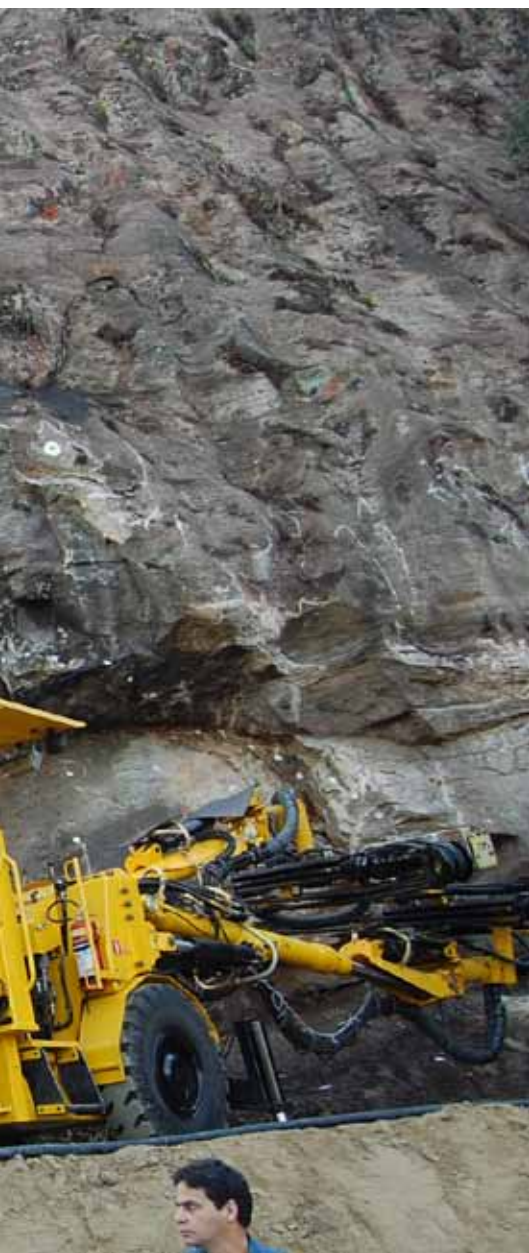
◀ Tratamento no maciço de rocha da Pedra da Gávea, onde está sendo escavado o túnel da linha 4 do metrô carioca.
