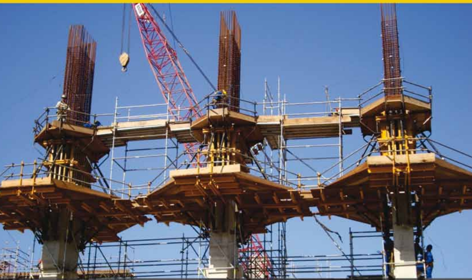
Estaleiro e Base Naval - Itaguaí - RJ - Consoles Trepantes
