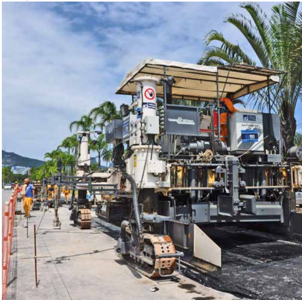
▲ Obras ocorrem em região de alta concentração populacional, além de grande número de interferências
