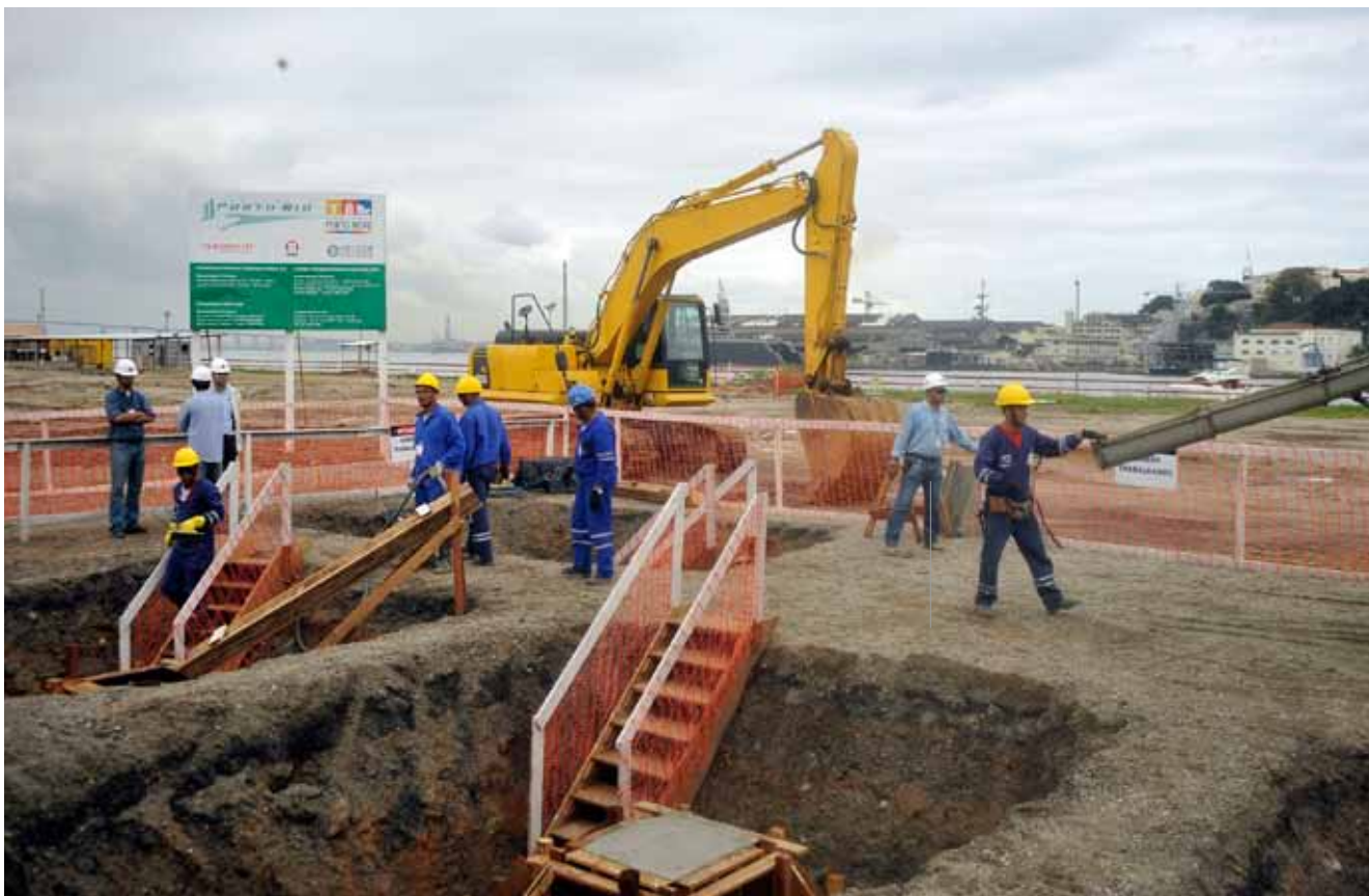
▲ Início das obras reforço estrutural do Píer Mauá e fundações do Museu do Amanhã
