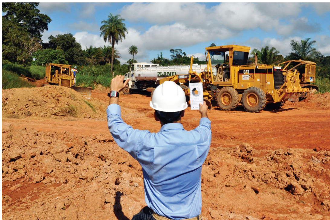
◀ Os canteiros estão sendo montados para receber os trabalhadores, um exército de 20 mil operários em plena mata
