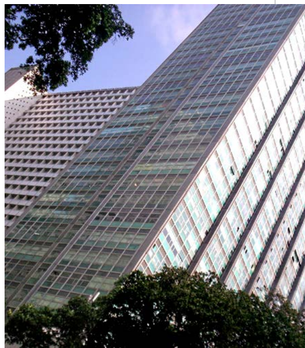
▲ Edifício Avenida Central, primeiro prédio do centro do Rio de Janeiro erigido em estrutura metálica, em lugar do concreto armado
