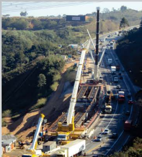
Ponte na CCR Nova Dutra - 300 toneladas
