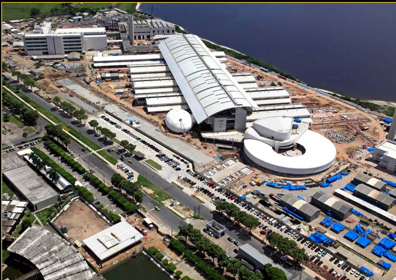
▲ Novo Centro de Pesquisas da Petrobras (Cenpes), no Rio de Janeiro, um dos mais recentes projetos de grande porte de Zanettini, que tem o aço como elemento de destaque
