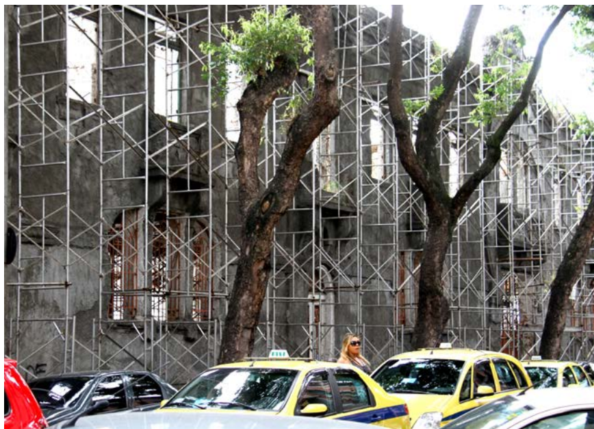
◀ Recuperação da fachada da Vila Rui Barbosa, construída em 1890, na esquina da Rua dos Inválidos com rua do Senado
