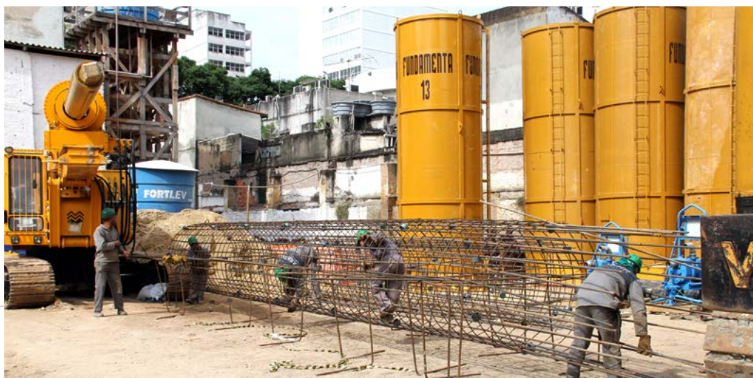
► Parte do canteiro de obras dedicado à concretagem dos pilares para as fundações
