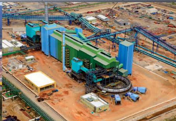
Outotec para TKCSA - Planta de sinterização - 9000 toneladas
