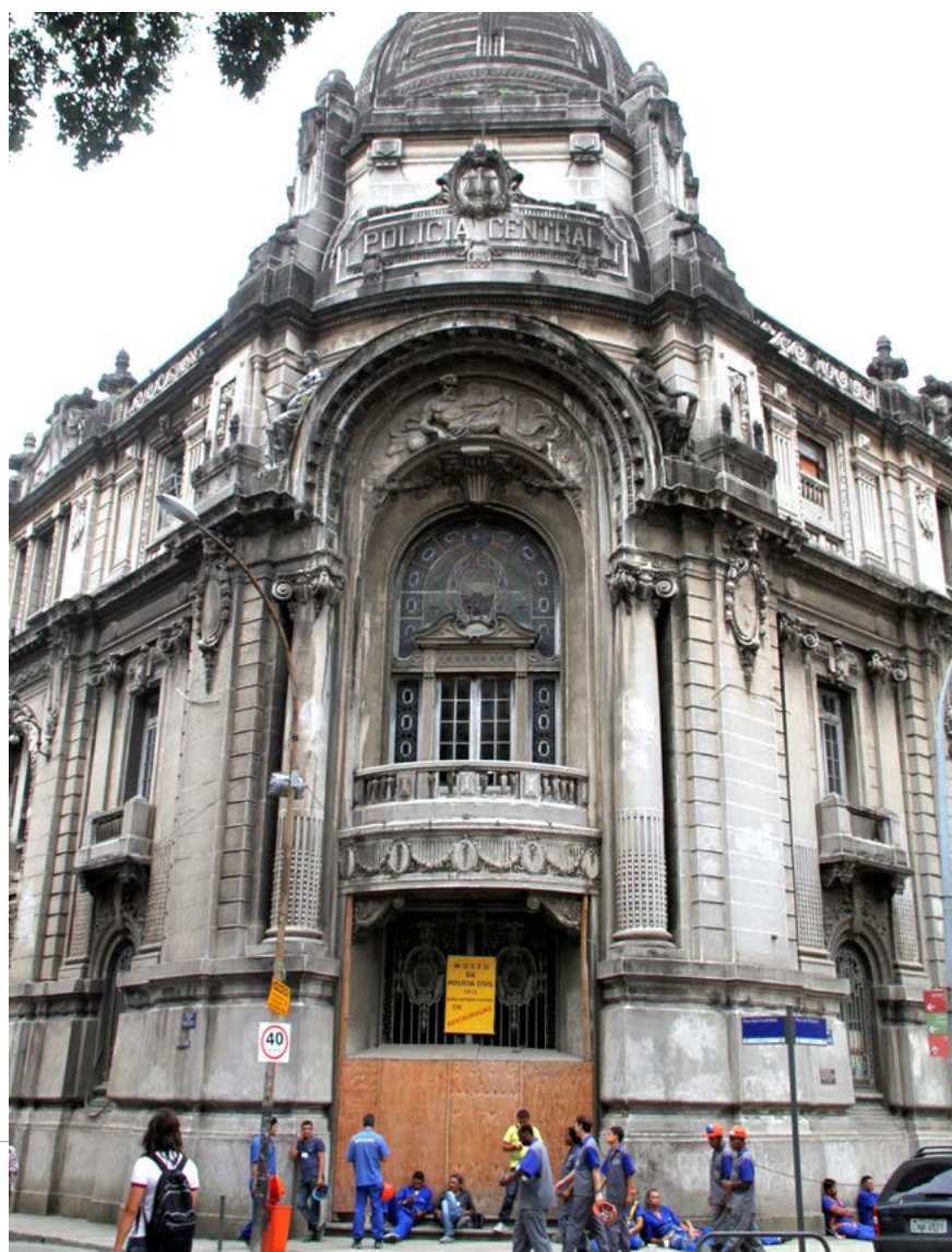
► Obras de recuperação do antigo edifício de Polícia Geral (que já abrigou as atividades do Dops) que provavelmente será transformado em museu.
