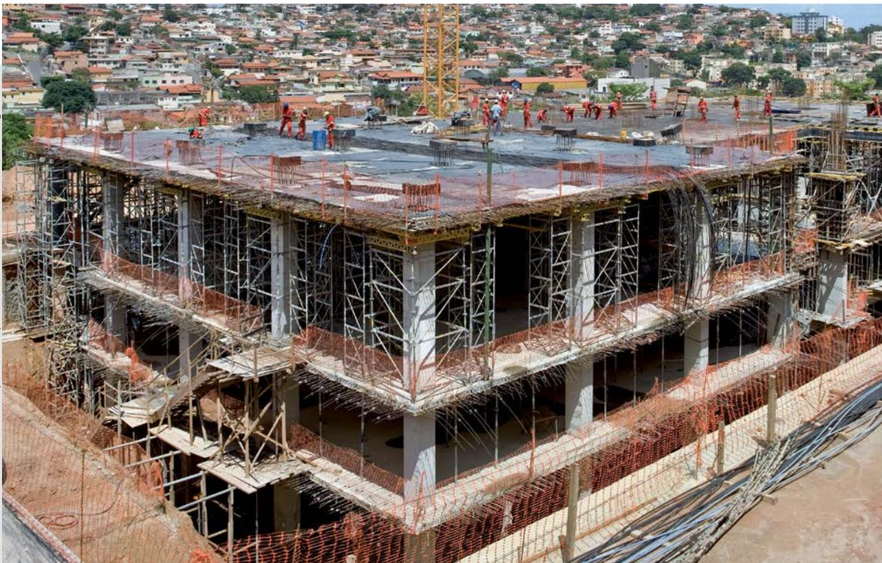
Processo fácil de montagem: Todos os componentes do sistema ST 100 são simplesmente encaixados, sem necessidade de porcas ou pinos.
