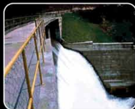
UHE Mello - Valesul, Rio Preto/MG
