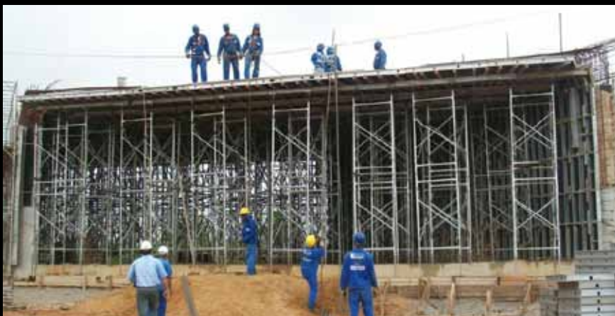
◀ andaimes da SH aplicados na construção de obra de arte rodoviária
