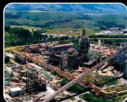
Gerdau Açominas, Ouro Branco/MG
