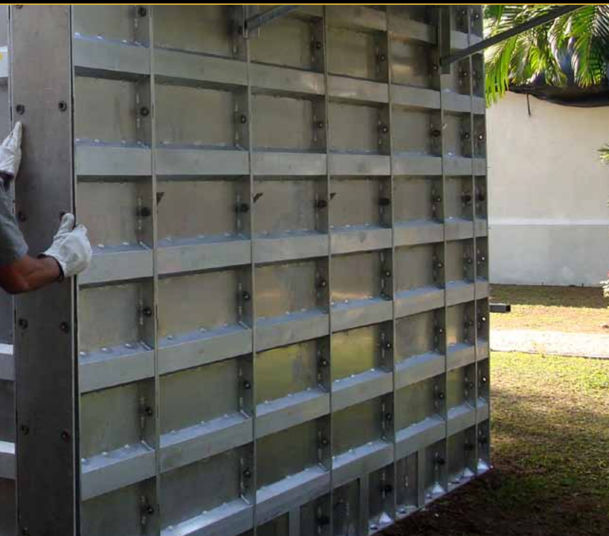
◀ Formas SH para paredes de concreto, utilizadas na construção de habitações populares: até uma casa concretada por dia
