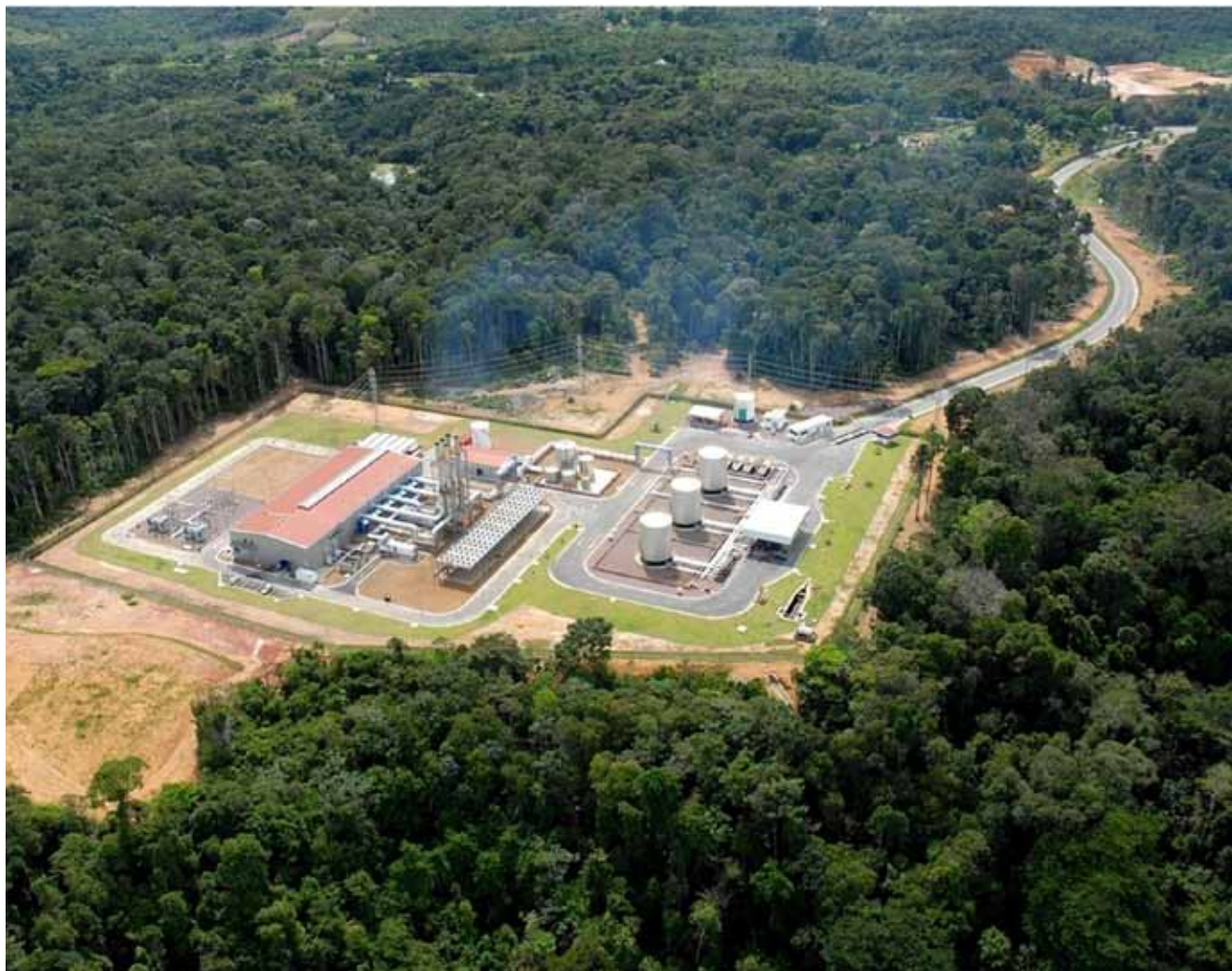
▲ Usina Termelétrica Manauara, em Manaus (AM), convertida para gás natural
