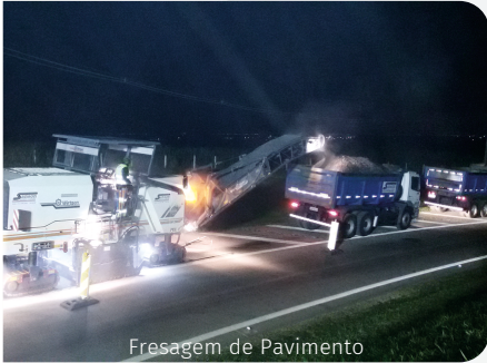
Fresagem de Pavimento
