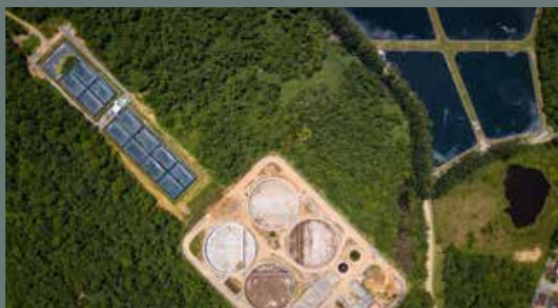
▲ Saneamento é a principal aposta de investimento em infraestrutura
