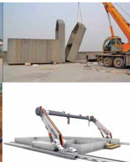
▲ Montagem de casas e "impressora" em 3D
