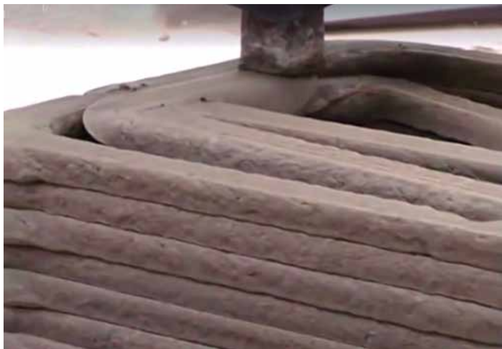
▲ Impressora aplicando o “concreto” para a confecção de paredes
