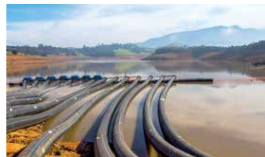
▲ Primeiras obras emergenciais começam a ser entregues
