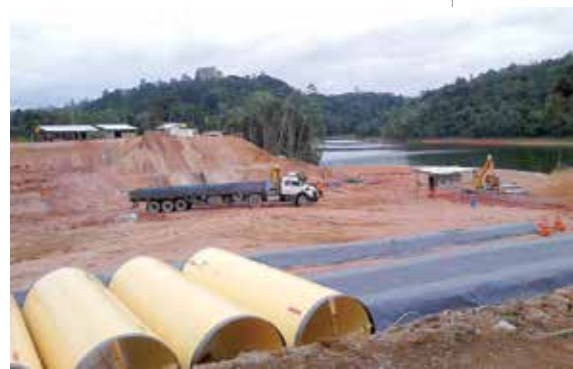
▲ Obras, em ritmo de urgência
