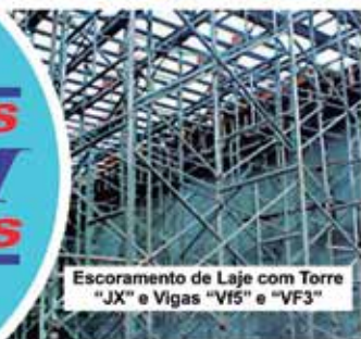
Escoramentos, andaimes, escadas de acesso com LEBLOK e tubos com braçadeiras - Rodonel Trecho Sul - SP
