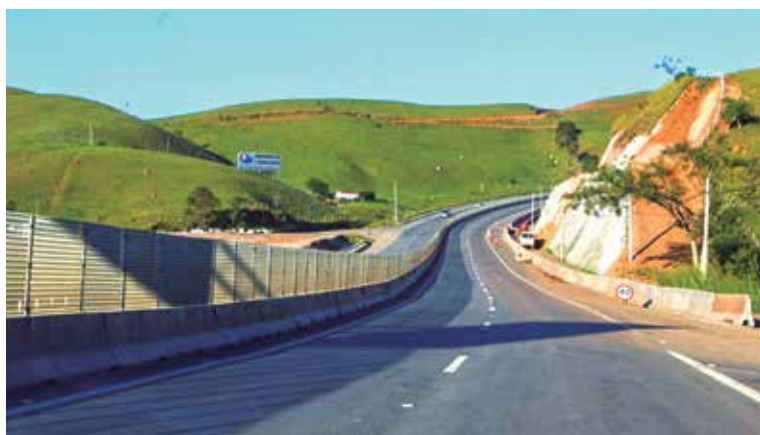
▲ Rodovia dos Tamoios, fundamental para o escoamento de produtos via Porto de São Sebastião
