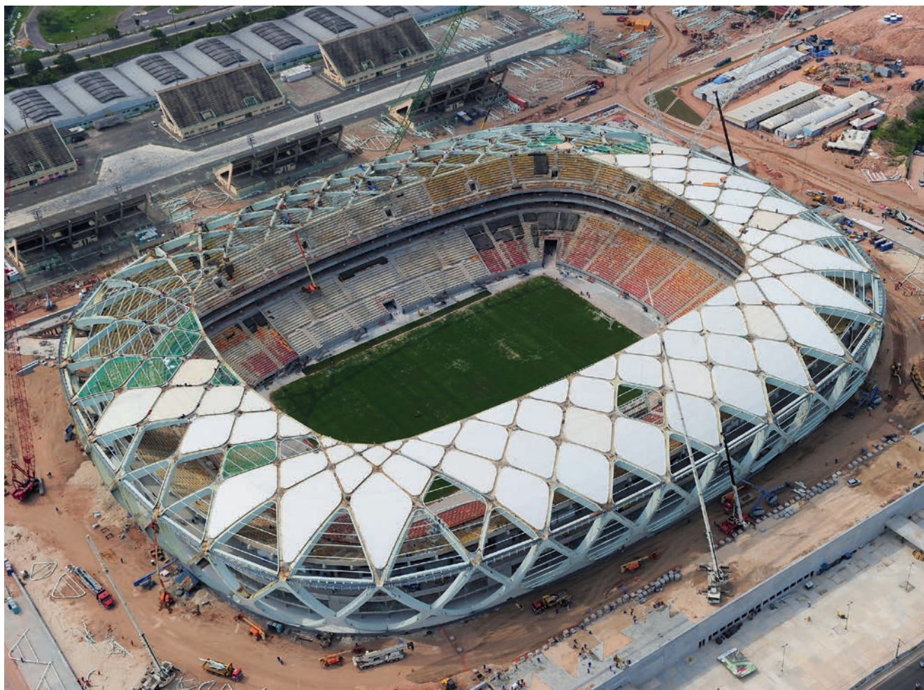
▲ Conceitos do Lean Construction já são aplicados em grandes obras no Brasil, como a Arena da Amazonia
