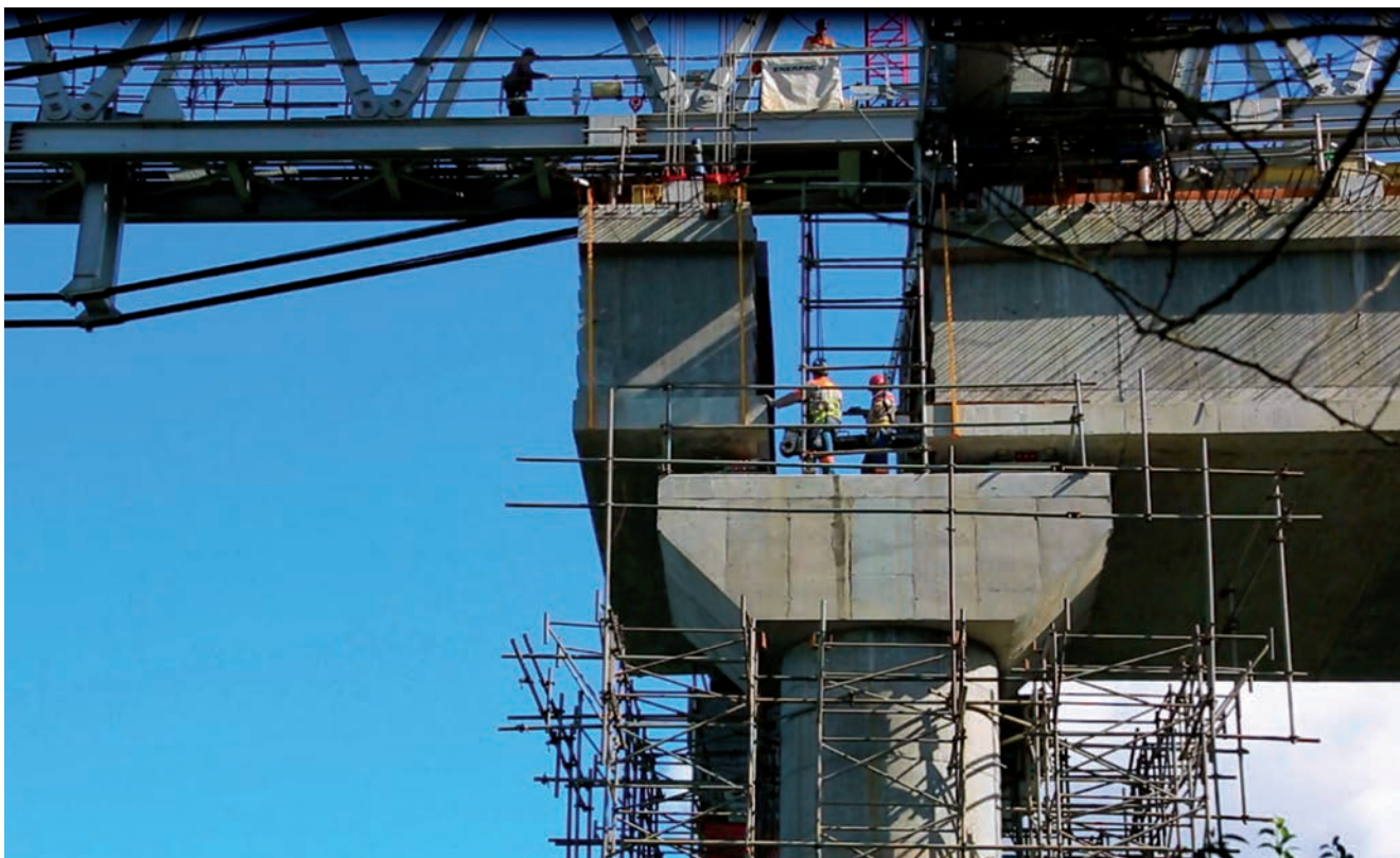
▲ A treliça metálica em ação, alinhando as aduelas de concreto para a montagem do tabuleiro da ponte
