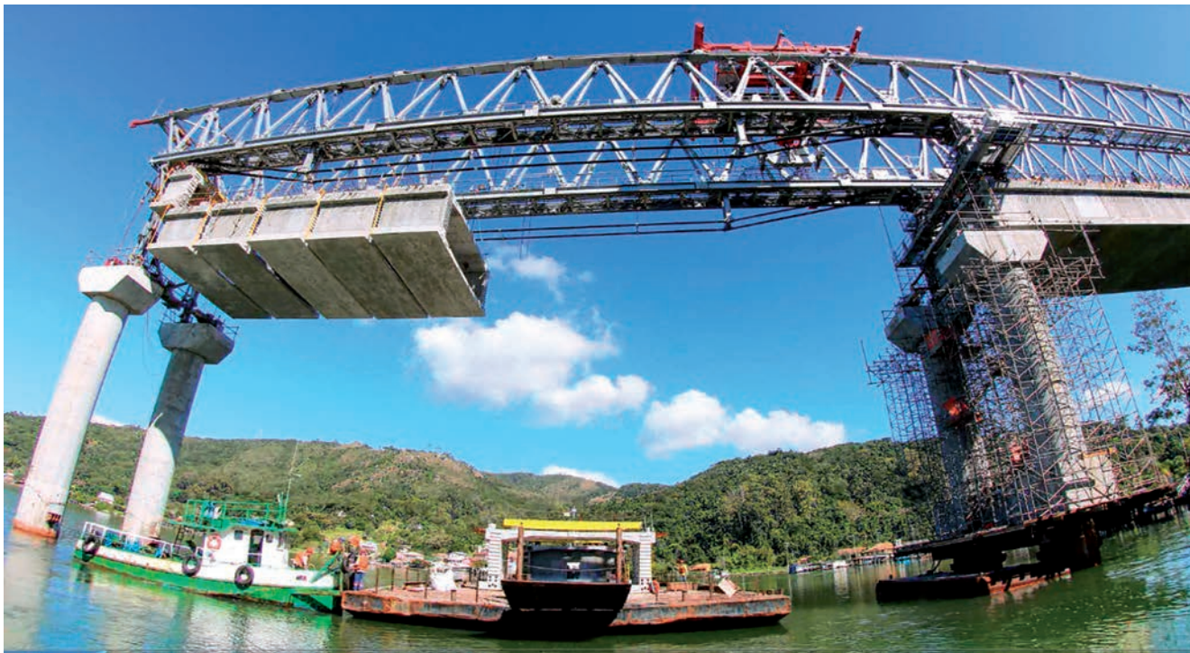
▲ Dezenas de balsas e outras embarcações deram suporte às obras, na movimentação de operários, máquinas e materiais
