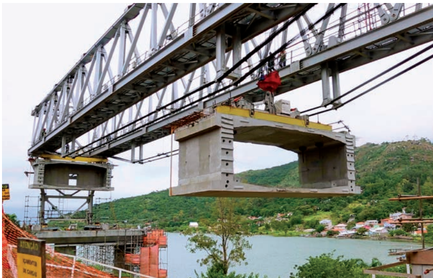
◀ O projeto exigiu a colocação de 658 aduelas, cada uma pesando cerca de 90 toneladas
