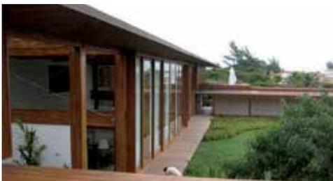
Obra residencial com planta na forma de um H e sistema estrutural com pórticos modulados. Levando em conta que a estrutura utiliza Madeira Laminada Colada (MLC), foram consideradas as cargas normais de edificações, mas com rigorosa consideração do efeito do vento, principal-
