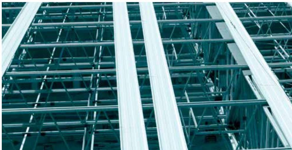
▲ Cobertura metálica, da Zipco: painéis zipados sem emendas
