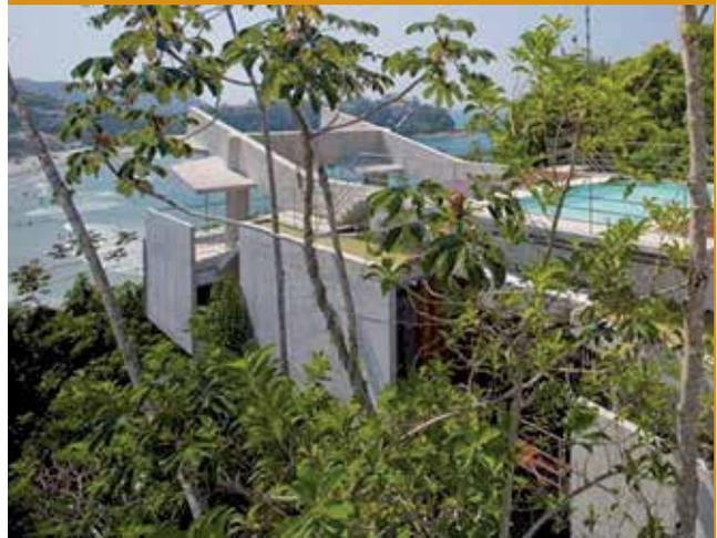
Projeto em concreto armado com três pavimentos, apoiado em apenas três pilares. Trata-se de uma estrutura particular totalmente pendurada e integrada, utilizando como base o concreto, o vidro e a madeira. A edificação foi construída sobre um terreno inclinado, com a preservação da vegetação natural.
