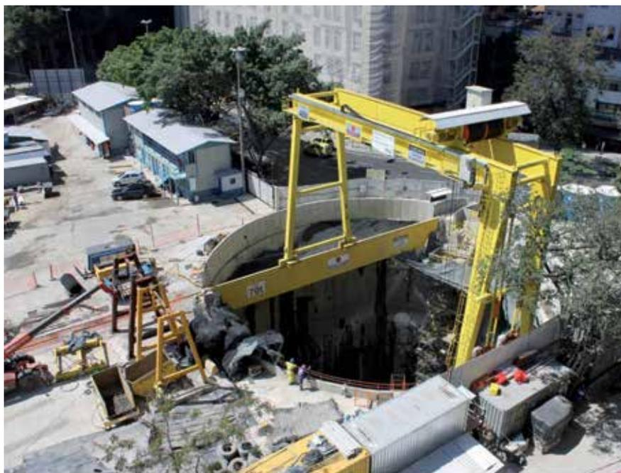
▲ Escavação de poço de serviço com detonação controlada
