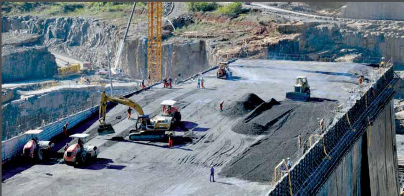
▲ Método de concretagem permitiu a execução simultânea de diversos serviços, permitindo a redução do prazo em comparação com o sistema convencional
