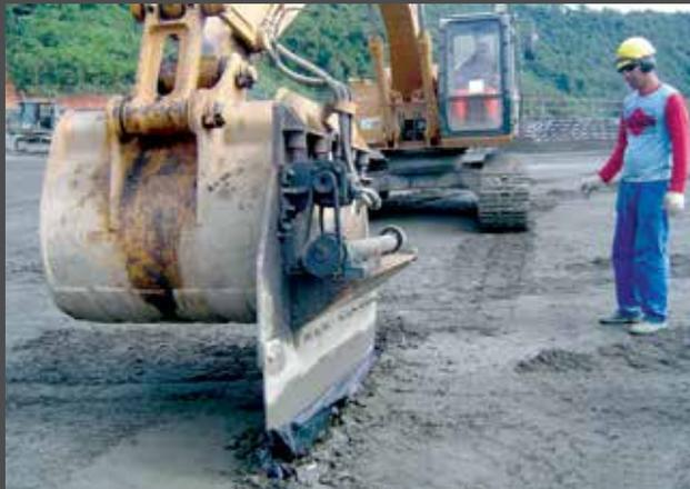
A barragem da usina Mauá foi construída por meio do método de concreto rampado, metodologia há mais de 10 anos empregada na China, mas inédita no Brasil até então, no volume em que a técnica foi empregada nesta obra. O sistema consiste em criar uma base inicial de grande extensão da barragem, que permitirá a execução das demais etapas (montagem de formas, concretagem, tratamento da superfície) de maneira contínua, sequencial e em escala volumétrica. “É quase uma linha de produção”.
