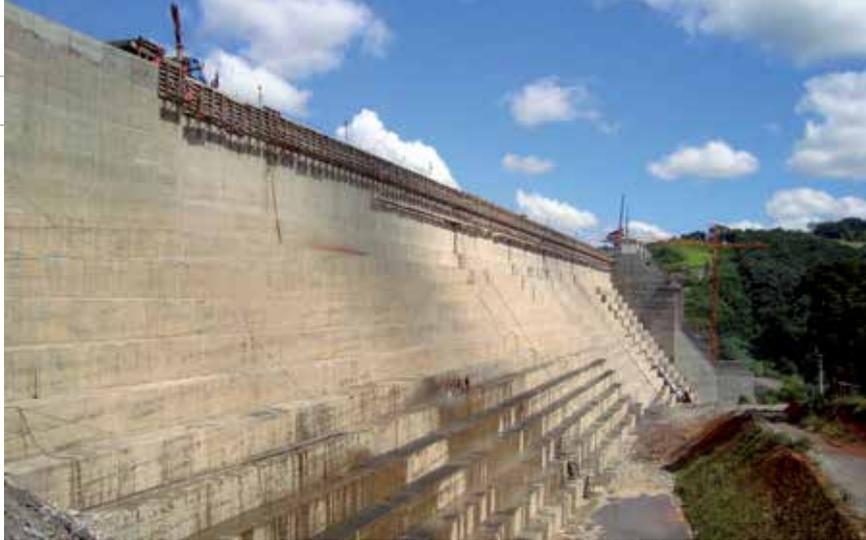
m (que é a altura de cada um dos degraus que formam a barragem) para cada bloco da construção, com extensão média de 20 m. Dessa maneira, o tamanho da área de espalhamento e compactação do concreto foi limitado, aumentando o intervalo de tempo entre as camadas e proporcionando mais tempo para secagem do concreto, o que dispensou o uso de argamassa colante”, disse Lamy.
