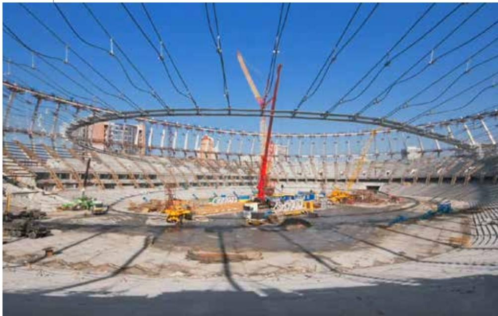
◀ No içamento dos cabos da cobertura da Fonte Nova foram usados 36 macacos hidráulicos, importados da Suíça, operados por central computadorizada
