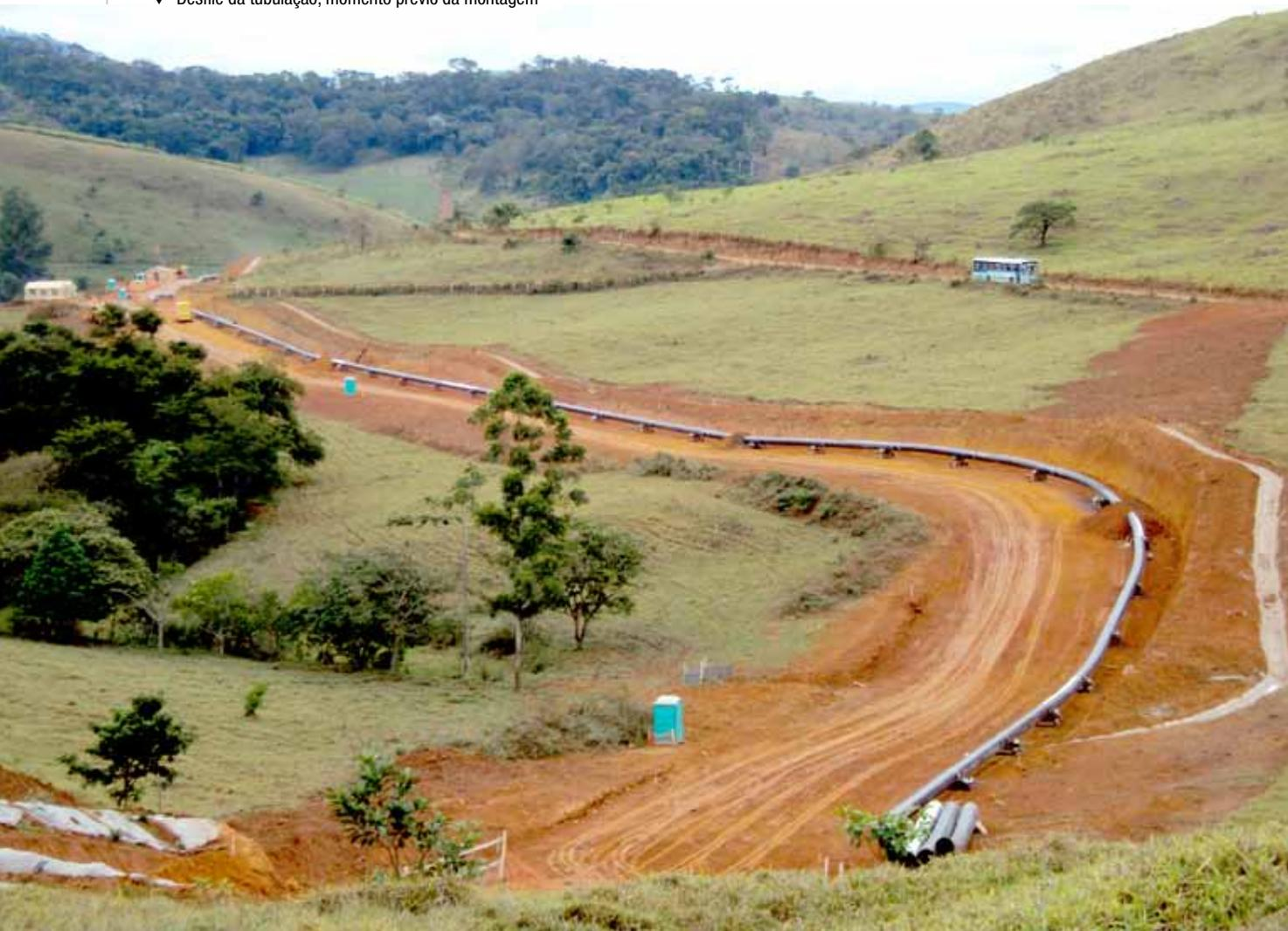
ção e montagem do duto, é instalada a drenagem de faixa ou drenagem superficial, que permite o escoamento das águas das chuvas através da faixa de servidão até os pontos de descarte final, nos despótics de drenagem.
