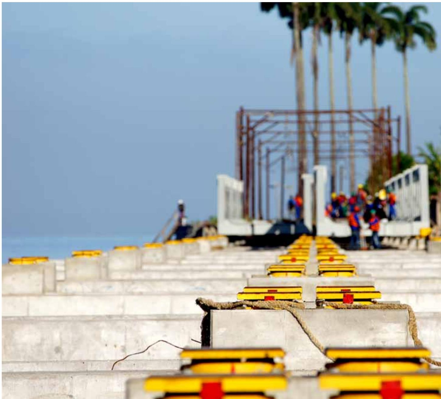
▲ A nova ponte empregou, no total, 950 t de perfis metálicos de aço patinável, 250 t de chapas de aço patinável, 25 t de parafusos e 25 t de solda
