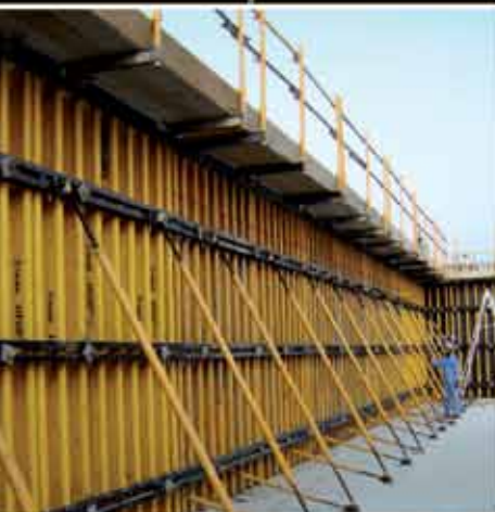
ENKOFORM V-100 a fôrma versátil e para usos repetiti- vos com excelente acabamento
