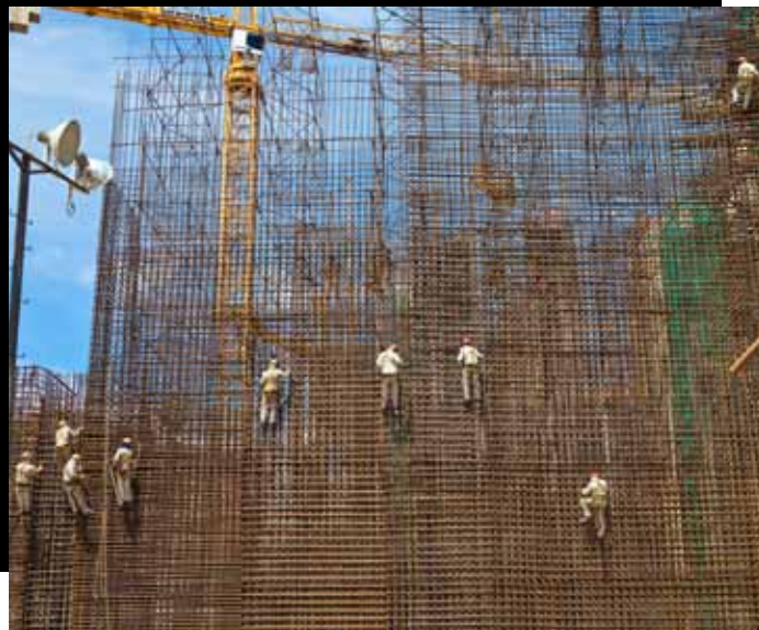
▲ Equipamentos e planejamento garantem o ritmo das obras
