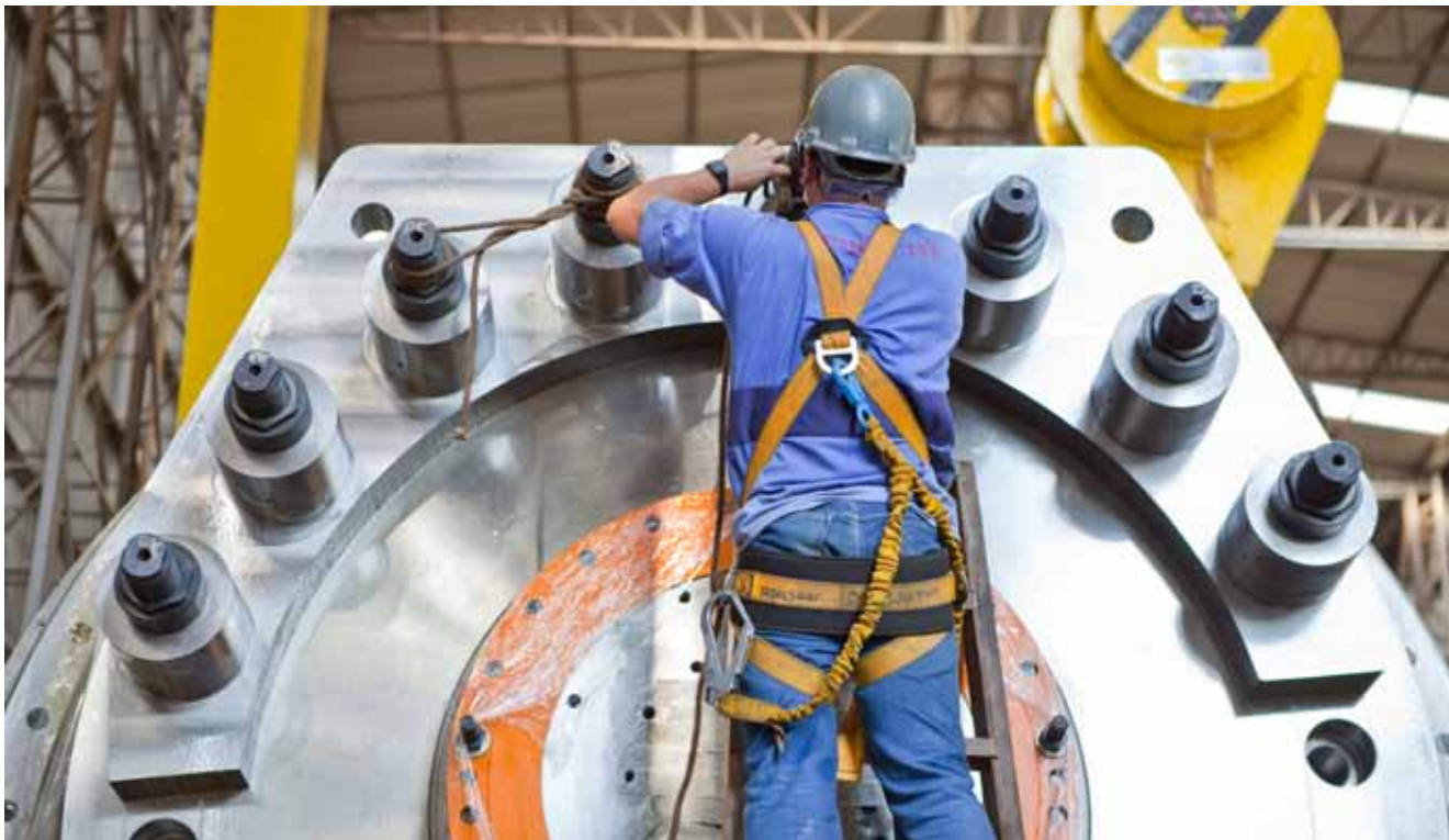
▲ Área de montagem em plena operação
