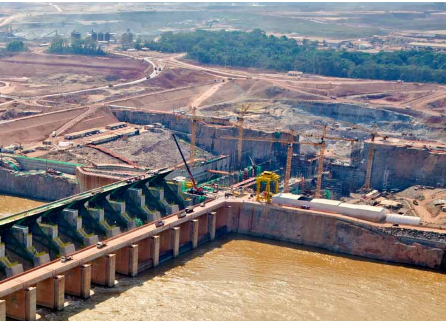
▲ Usina está com mais de 50% dos serviços concluídos
