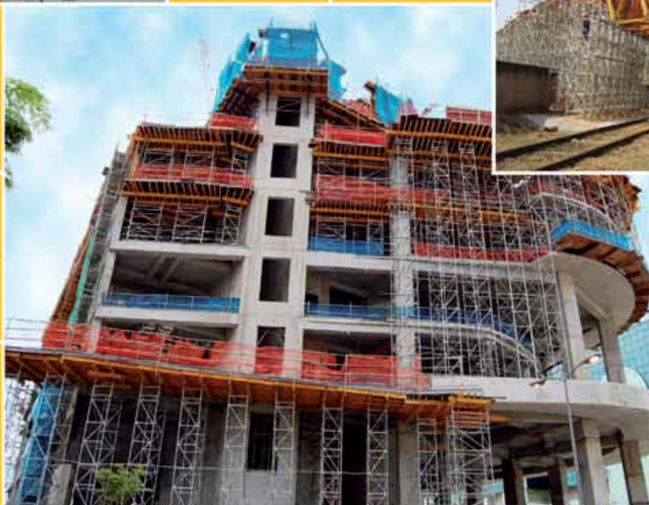
Címbre T-60 o escoramento robusto e versátil para múltiplas aplicações
