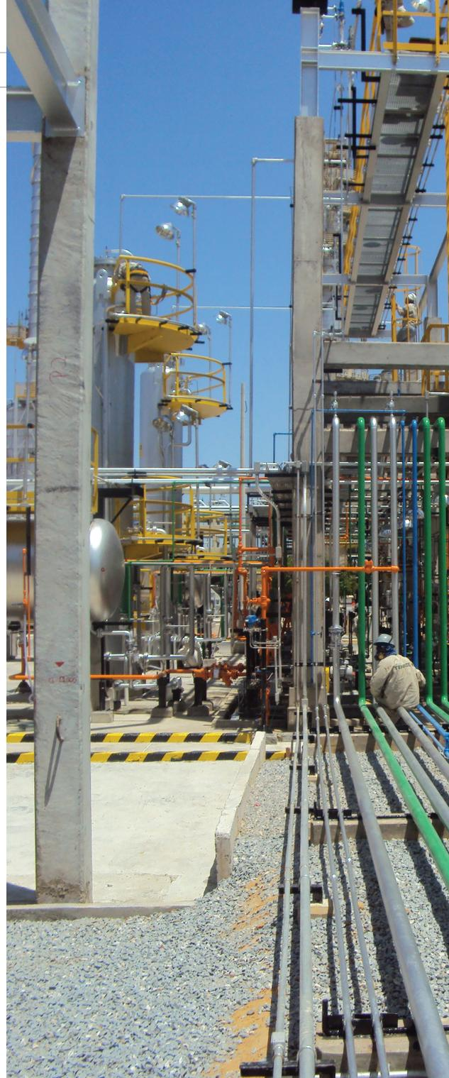
A refinaria tem área total de 25 mil m<sup>2</sup> e área construída de 20 mil m<sup>2</sup>. O escopo do contrato previu a construção de 6 tanques de 30 m de diâmetro, 2 tanques de 17,5 m de diâmetro, recuperação e pintura interna de um tanque, montagem de 700 t de tubulação e de 22 bombas, ampliação e reforma de 3 subestações além da montagem de 150 t de estrutura metálica.
